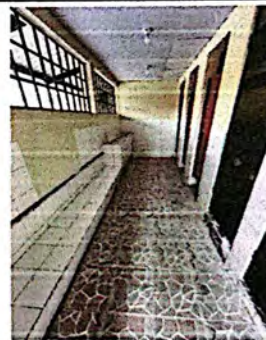
Foto 10: Suministro e instalación de piso antideslizante + puertas.
