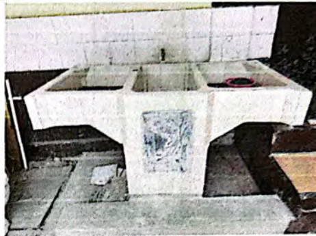
Foto 8: Instalación de azulejo en pila.
