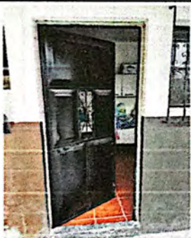
Foto 9: Instalación de puerta metálica con chapa.
