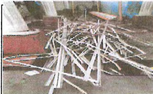
Foto 4: DIA 18 CONTINUACION DE TRABAJOS
