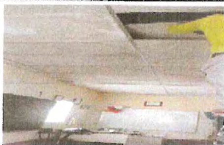
Foto 3: DIA 15 CONTINUACION DE DESMONTAJE DE CIELO FALSO
