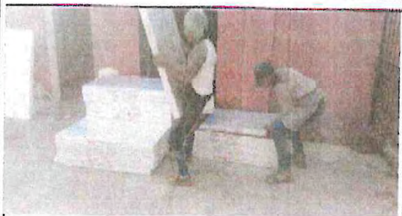
RECEPCION DE MATERIAL PARA
