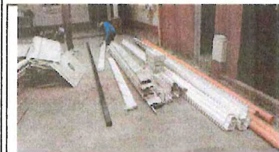
Fotografía 3: DÍA 16 RECEPCIÓN DE MATERIALES Y CONTINUACIÓN DE TRABAJOS
