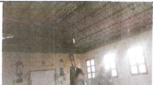
Foto 3: DIA 15 CONTINUACION DE DESMONTAJE DE CIELO FALSO
