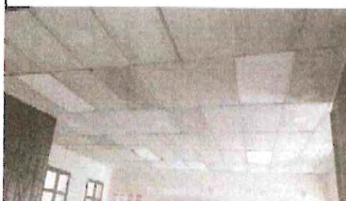
Foto 3: DIA 16 CONTINUACION DE DESMONTAJE DE CIELO FALSO
