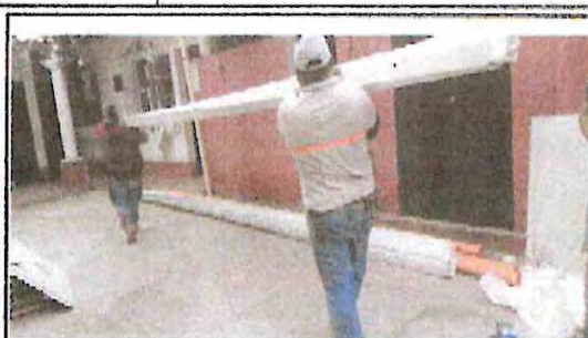
Fotografía 2: DÍA 16 RECEPCIÓN DE MATERIALES Y CONTINUACIÓN DE TRABAJOS
