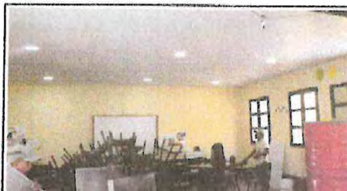
INSTALACION DE CIELO FALSO
