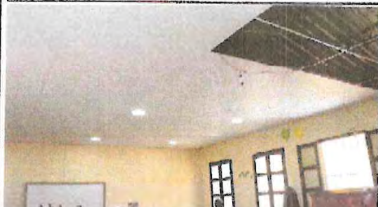
INSTALACION DE CIELO FALSO
