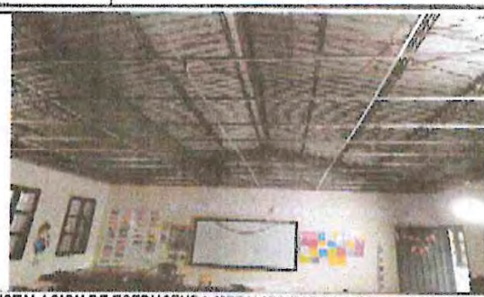
INSTALACION DE ESTRUCTURA METALICA PARA LA COLOCACION DEL CIELO FALSO
