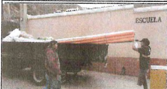
Fotografía 1: DÍA 16 RECEPCIÓN DE MATERIALES Y CONTINUACIÓN DE TRABAJOS
