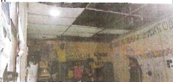
Foto1: DIA 15 CONTINUACION DE TRABAJOS EN CIELO FALSO
