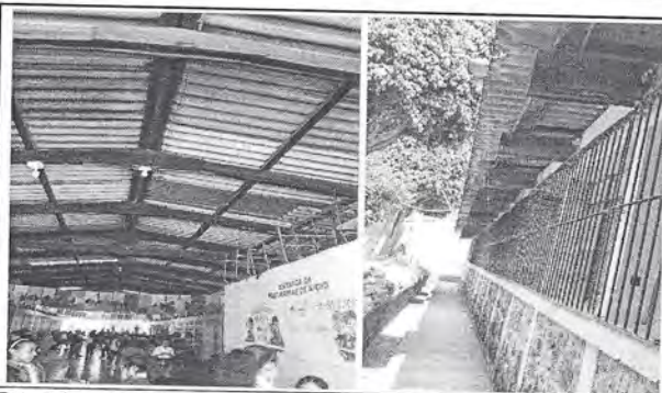
Foto 3: Imagen que muestra el estado actual del techo de duralita y la estructura portante de madera, del módulo de aulas a intervenir.
