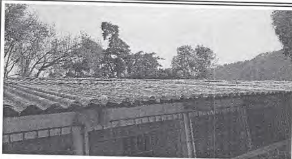
Foto 1: Imagen que muestra el estado actual del techo de duralita y la estructura portante de madera, del módulo de aulas a intervenir.
