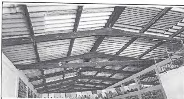
Foto 5: Imagen que muestra el estado actual del techo de duralita y la estructura portante de madera, del módulo de aulas a intervenir.
