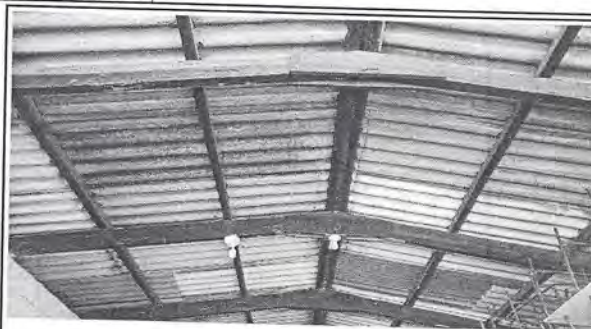
Foto 2: Imagen que muestra el estado actual del techo de duralita y la estructura portante de madera, del módulo de aulas a intervenir.
