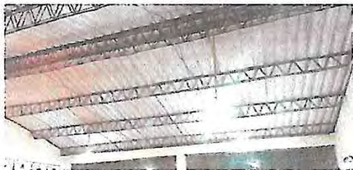
Foto 5: láminas que se desinstalarán e instalarán para corrección de goteras
