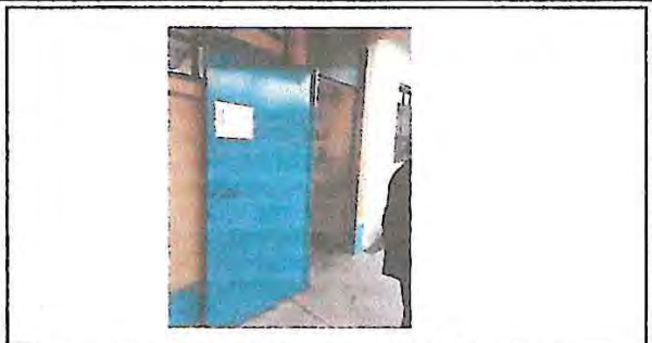
Foto 8: limpieza y pintura de puertas
