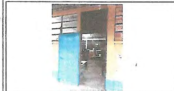
Foto 9: limpieza y pintura de puertas
