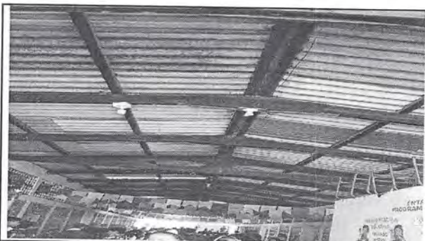
Foto 5: Imagen que muestra el estado actual del techo y la estructura portante de madera, del módulo de aulas a intervenir.
