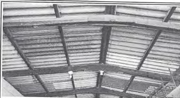
Foto 2: Imagen que muestra el estado actual del techo y la estructura portante de madera, del módulo de aulas a intervenir.
