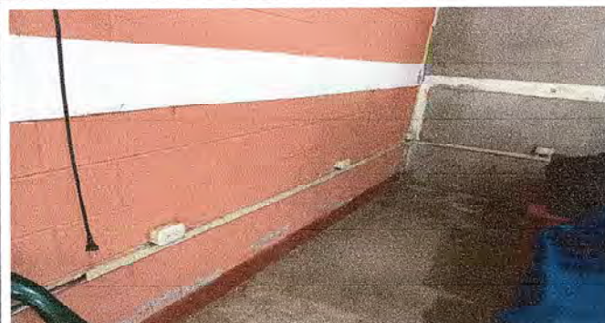
FOTO 2: Finalización del sistema eléctrico.
