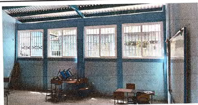
FOTO 15: Colocación de ventanas de pvc.
