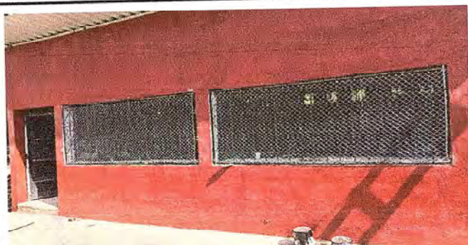
FOTO 13: Finalización de pintura en la pared.
