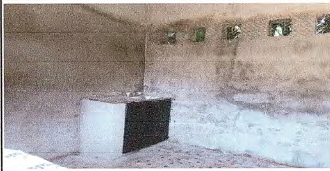
FOTO 6: Colocación de lavatrastos de metal.
