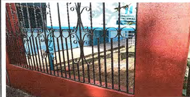
FOTO 12: Colocación de varillas de los balcones .
