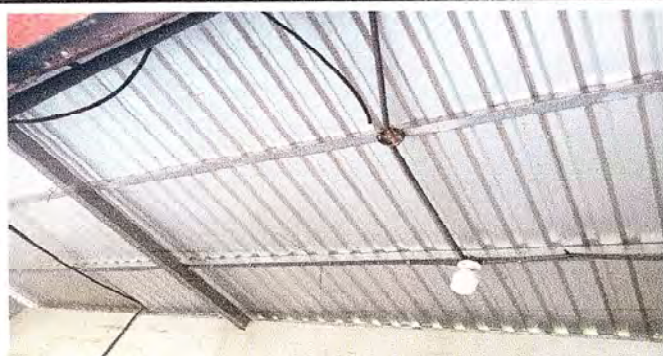
FOTO 7: Finalización de montaje de la estructura metálica + techo de lámina.
