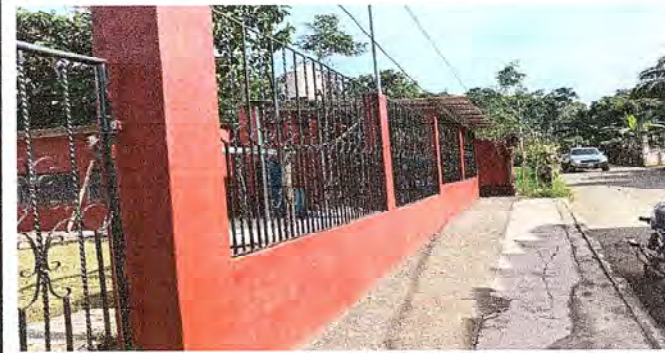
FOTO 10: Finalización de balcones .
