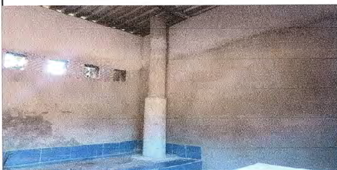
FOTO 1: Finalización de tubo de concreto
