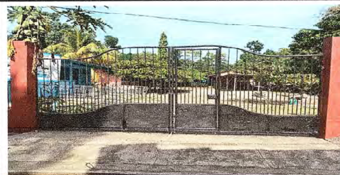
FOTO 11: Finalización de reparación de porton .
