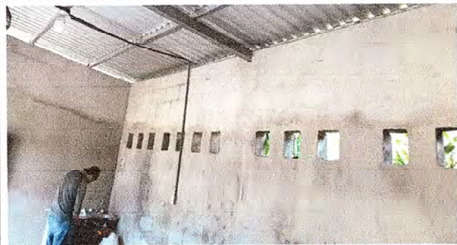
FOTO 8: Finalización de repello de pared.
