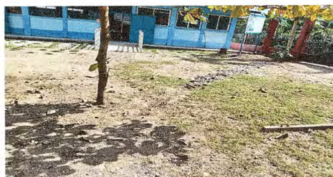
FOTO 9: Colocación de la línea principal de agua y drenaje.
