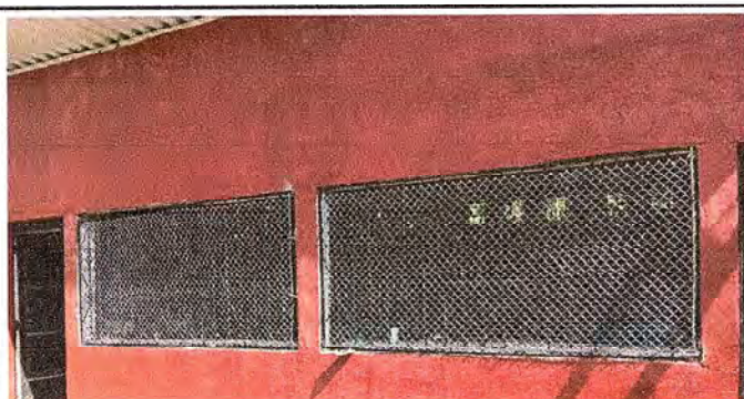
FOTO 3: Finalización de malla .
