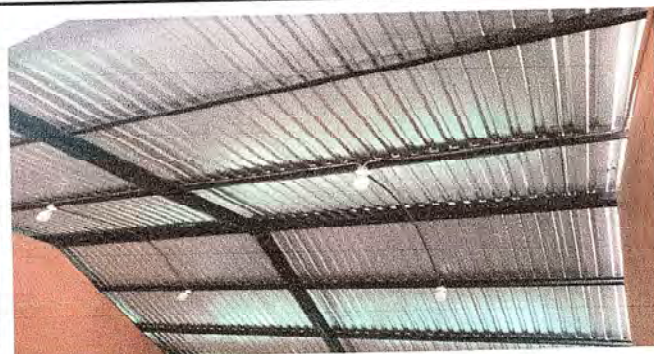
FOTO 14: Colocación de lámina.
