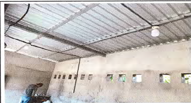
FOTO 4: Finalización de la elevación de pared.
