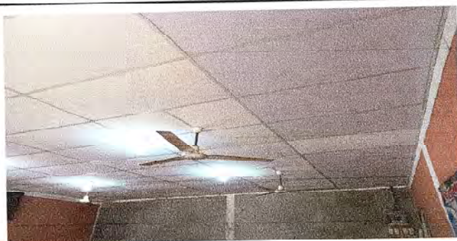
FOTO 17: Colocación de cielo falso.
