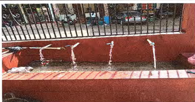
FOTO 5: Colocación de los cuatro chorros.
