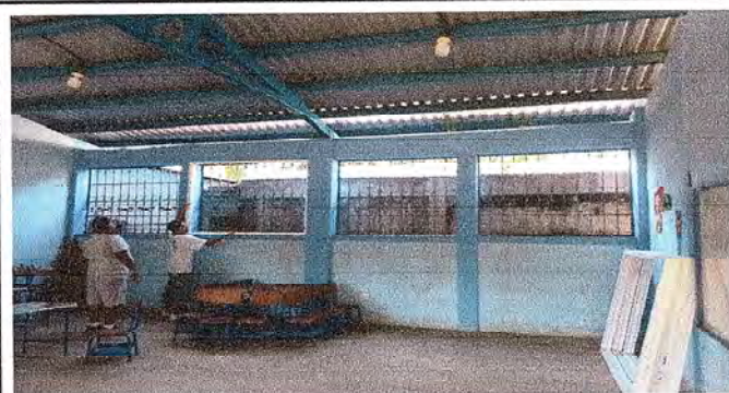
FOTO 15: Se observa la puesta de ventanas pvc.
