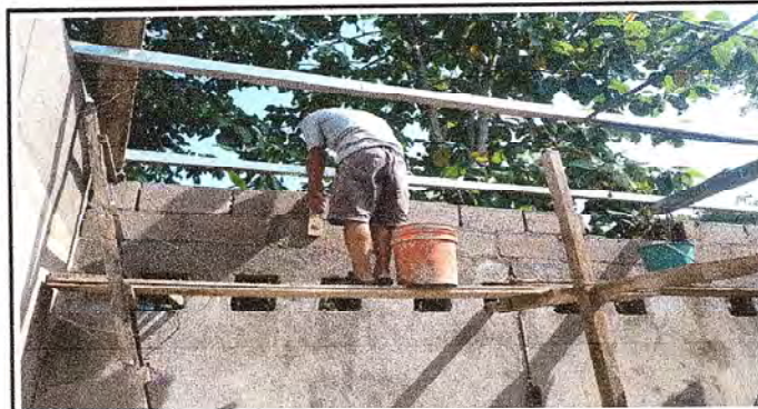
FOTO 4: Elevación de pared en cocina.
