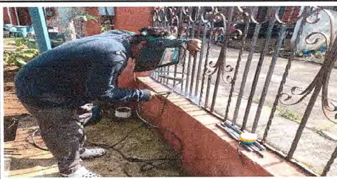
FOTO 12: Se observa la colocación de barillas en balcones.
