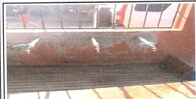
FOTO 5: Sustrucción de 4 chorros que estaban en mal estado
