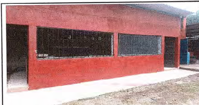
FOTO 3: Colocación de malla en balcones.
