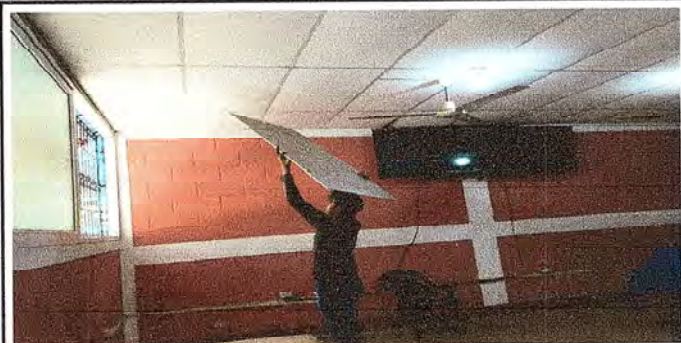
FOTO 17: Se observa el arreglo del cielo falso.
