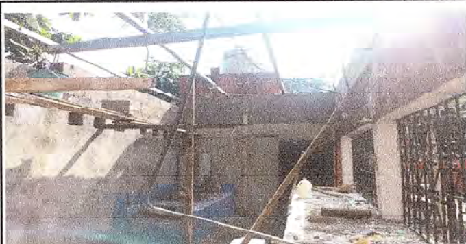
FOTO 7: Desmontaje de estructura metálica
