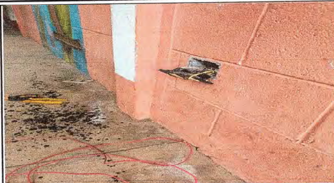
FOTO 2: Reparación de sistema eléctrico
