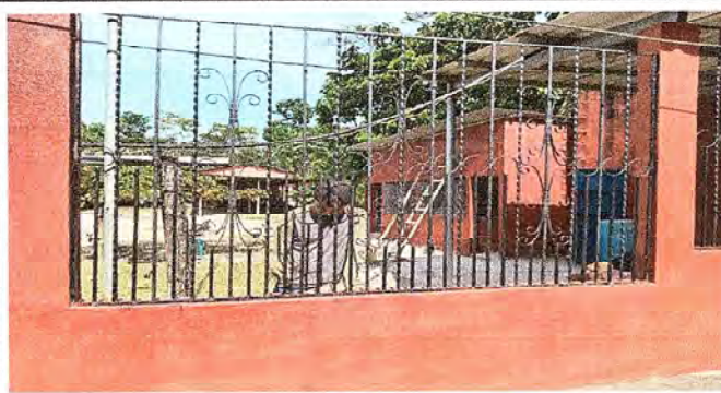
FOTO 10: Se observa mantenimiento de balcones.
