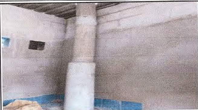
FOTO 1: Sustrucción de tubo de concreto
