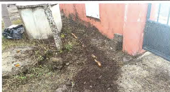
FOTO 9: Drenaje de agua
