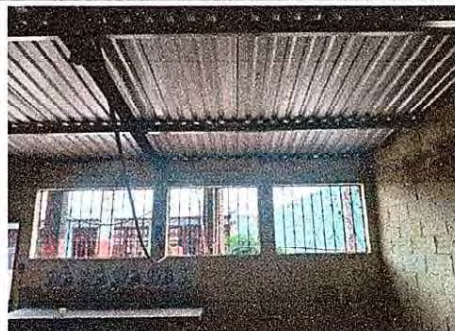
Foto 8: Cambio de las láminas deterioradas.
