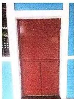
Foto 11: Mejoramiento de la puerta que estaba oxidada.
