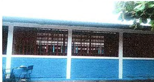
Foto 12: Mejoramiento de las pares que se encontraban sucias y sin pinturas.
