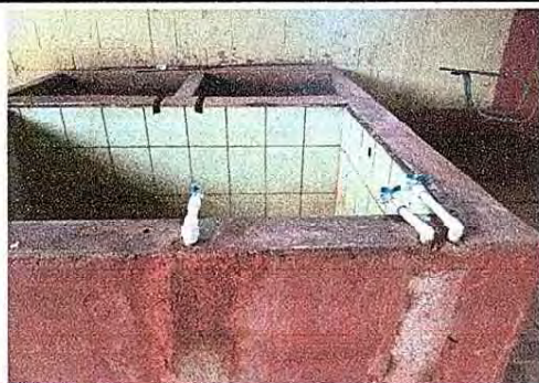
Foto 9: Mejoramiento de los grifos.
