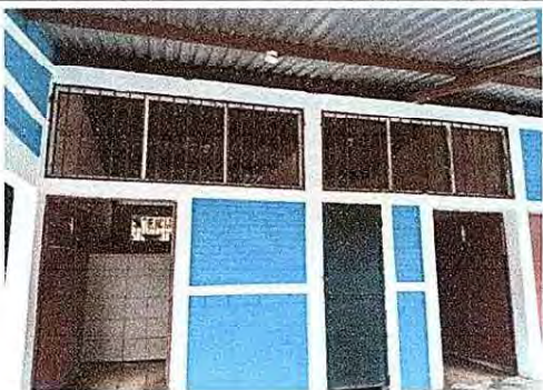
Foto 7: Colocación de balcones de metal.
