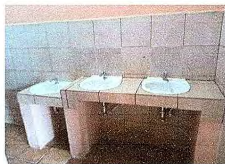
Foto 6: Instalación de un lavamos faltante.
