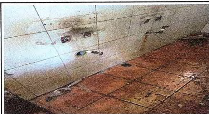
Foto 3: Se observa el desmontaje de los lavamanos antiguos.
