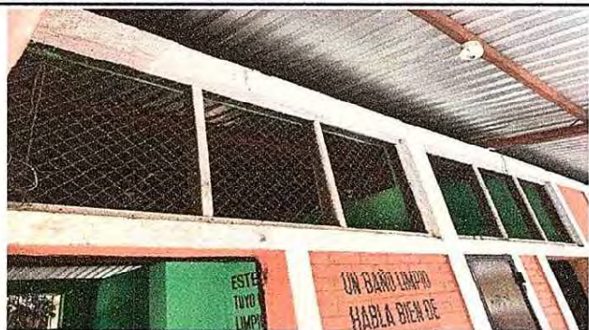
Foto7: Mejoramiento de ventanas con la implementación de balcones de metal.
