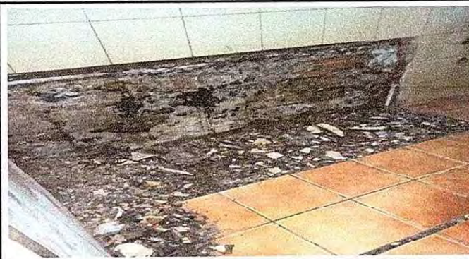
Foto 2: Se observa la demolición del migitorio antiguo.
