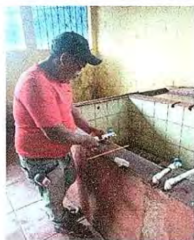
Foto 9: Cambio de los tubos de los grifos.
