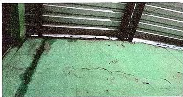
Foto 5: Inicio del mejoramiento de las paredes.
