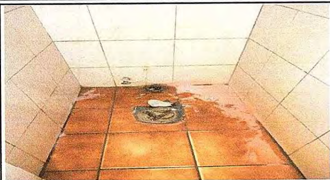
Foto 1: Se observa la fase intermedia el sanitario antiguo ya desmontado.
