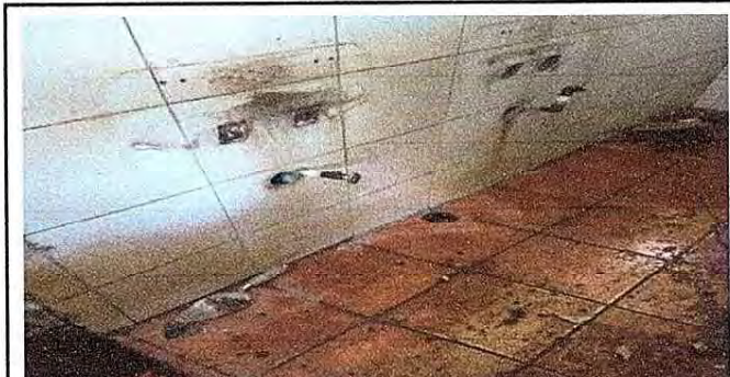
Foto 6: Se observa el desmontaje de los lavamanos antiguos.
