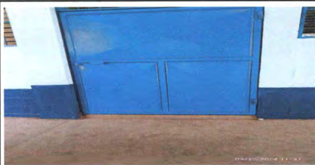
FOTO 9 MANTENIMIENTO DE PUERTAS DE METAL EN SALONES Y SANITARIOS , LIJADO CEPILLADO Y APLICADO DE PINTURA
