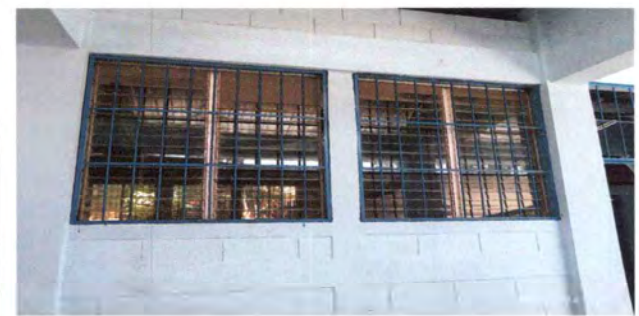
FOTO 10 MANTENIMIENTO DE BALCONES EN SALONES Y SANITARIOS LIJADO Y APLICADO DE PINTURA.
