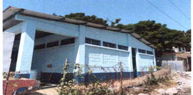
FOTO 8 RESANE Y APLICACIÓN DE PINTURA LATEX ACRILICA EN PAREDES EXTERIORES
