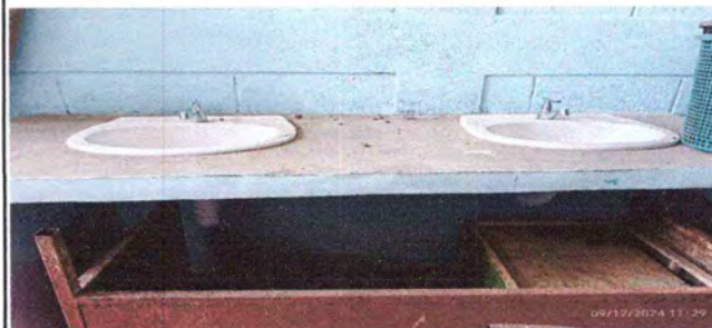
FOTO 6 REPARACIÓN DE LAVAMANOS INLCUYE CONTRALLAVE, TUBO DE ABASTO, SISTEMA HIDRAULICO Y SANITARIO EN BAÑOS DE HOMBRES Y MUJERES
