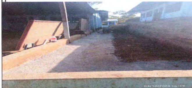
FOTO 1 REPARACIÓN DE CUNETAS DE CONCRETO
