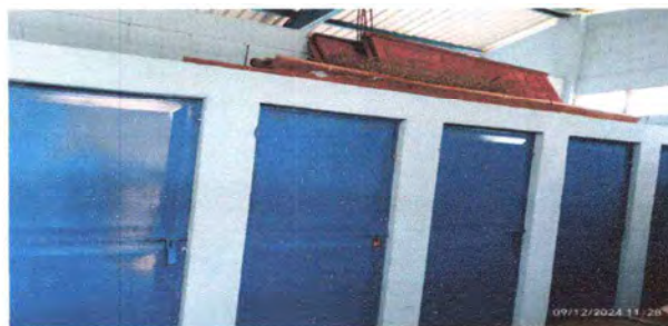
FOTO 4 SUSTITUCIÓN DE PUERTAS EN SANITARIOS.
