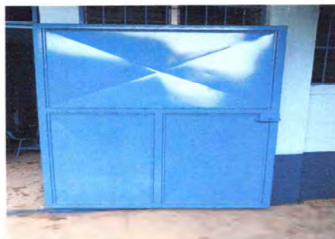
FOTO 9 MANTENIMIENTO DE PUERTAS DE METAL EN SALONES Y SANITARIOS , LIJADO CEPILLADO Y APLICADO DE PINTURA
