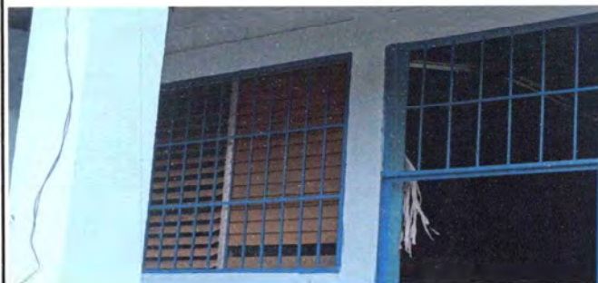
FOTO 10 MANTENIMIENTO DE BALCONES EN SALONES Y SANITARIOS LIJADO Y APLICADO DE PINTURA.
