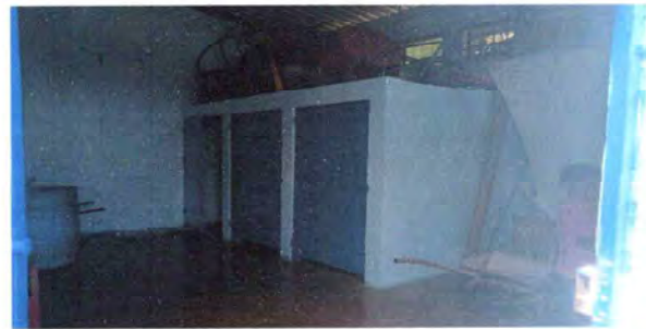
FOTO 4 SUSTITUCIÓN DE PUERTAS EN SANITARIOS.
