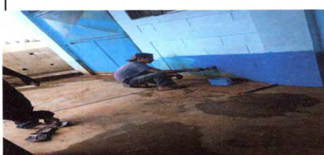
FOTO 8 RESANE Y APLICACIÓN DE PINTURA LATEX ACRILICA EN PAREDES EXTERIORES
