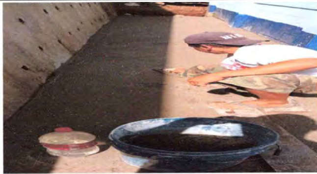
FOTO 1 REPARACIÓN DE CUNETA DE CONCRETO
