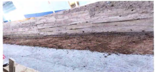
FOTO 2 SUSTITUCIÓN MURO EXISTENTE POR MURO DE CONCRETO CICLOPEO, APLICACIÓN DE SABIETA Y REPELLO
