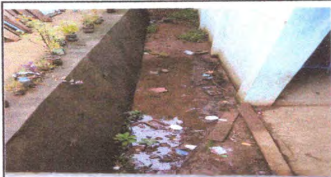
FOTO 1 REPARACIÓN DE CUNETA DE CONCRETO
