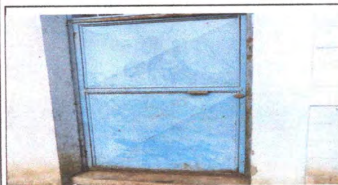
FOTO 9 MANTENIMIENTO DE PUERTAS DE METAL EN SALONES Y SANITARIOS , LIJADO CEPILLADO Y APLICADO DE PINTURA
