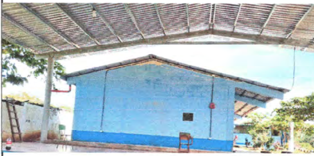
Foto 1: Finalización de sustitución de lamina MaxAlum en Escenario
