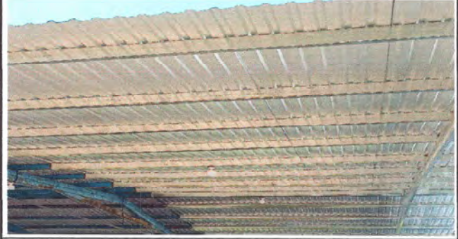
Foto 2: Finalización de cambio de estructura metálica en escenario
