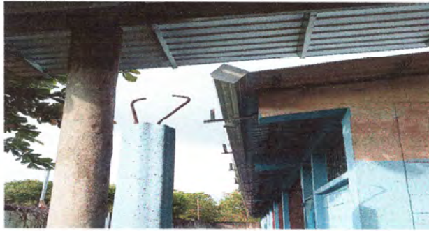
Foto 3: Finalización de instalación de canales de agua de metal y bajada de agua
