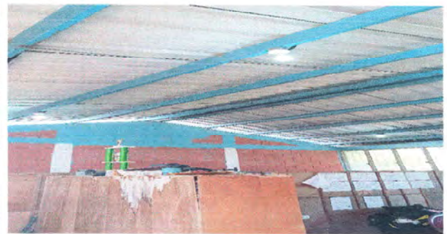
Foto 4: Finalización de reparación de sistema eléctrico.
