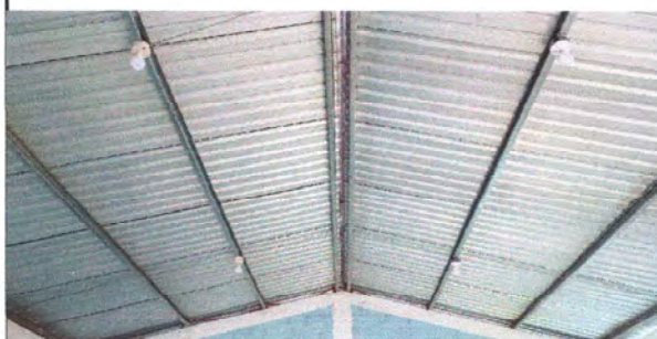
Foto 2: Finalización de ampliación y cambio de luminarias
