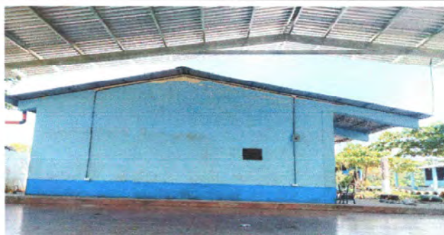
Foto 4: Finalización de ampliación de sistema eléctrico en escenario
