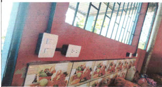
Foto 3: Finalización de implementación de tomacorrientes
