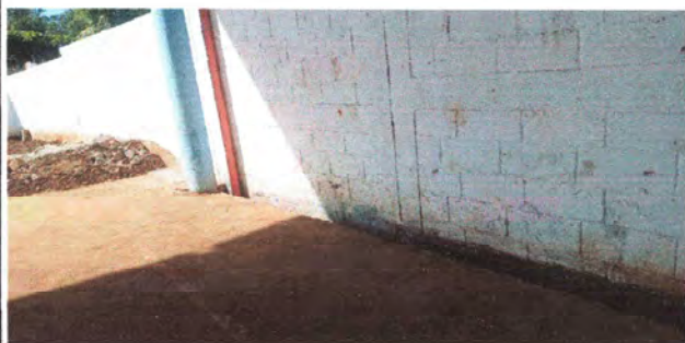
Foto 1: Finalización de Drenaje de canales de agua pluvial
