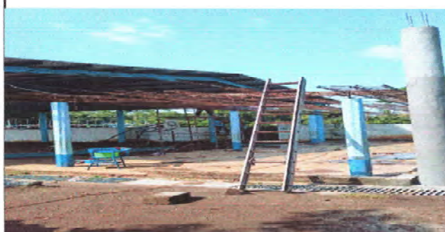
Foto 2: Se observa el proceso de cambio de estructura metálica y lamina
