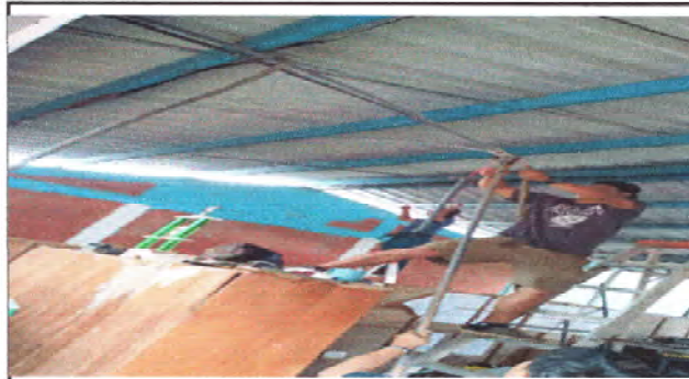
Foto 4: Se observa proceso de reparación de sistema eléctrico.
