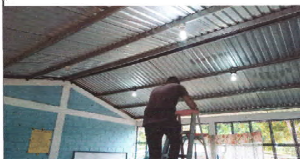
Foto 2: Se observa el proceso de ampliación y sustitución de luminarias.
