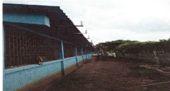
Foto 3: Se observa proceso de instalación de canales de agua de metal y bajada de agua
