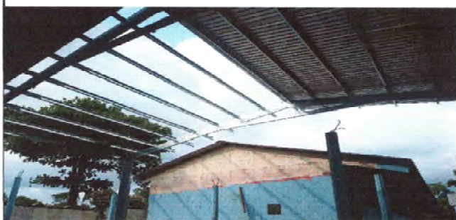
Foto 1: Se observa el proceso de sustitución de lamina de Escenario
