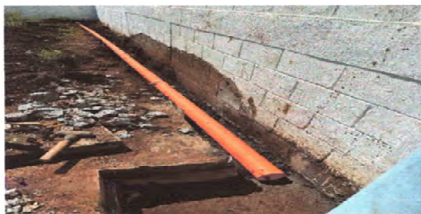
Foto 1: Se observa el proceso de drenaje de salida de agua pluvial
