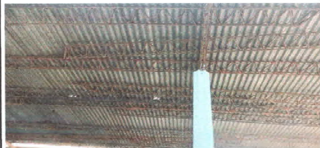
Foto 2: Se observa la necesidad de cambio de estructura metálica y lamina
