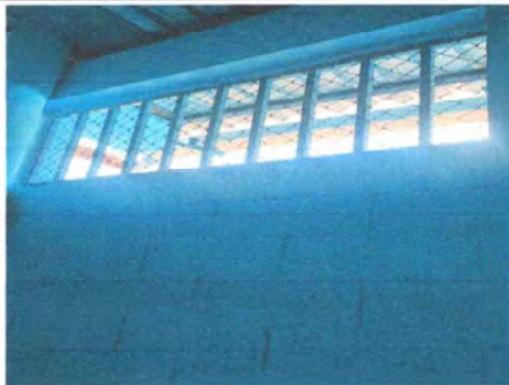
Foto 7: Mantenimiento de balcones de metal.
