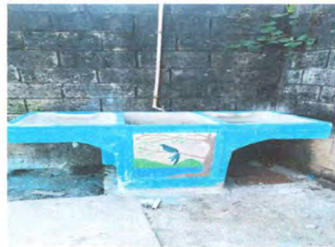
Foto 16: Sustitución de pila de cementode de 2 lavaderos.
