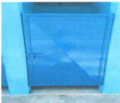
Foto 11: Sustitución de puertas de servicios sanitarios.
