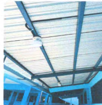
Foto 20: Sustitución de sistema eléctrico.
