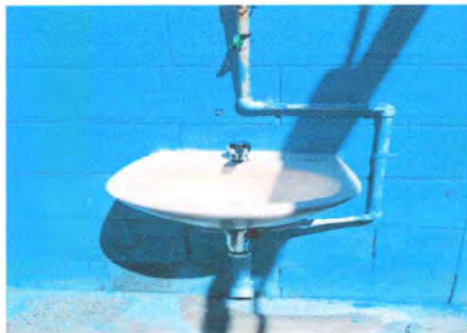
Foto 17: Sustitución de lavamanos.
