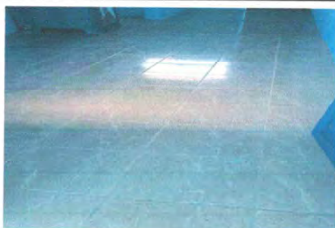
Foto 3: Sustrucción de piso cerámico.
