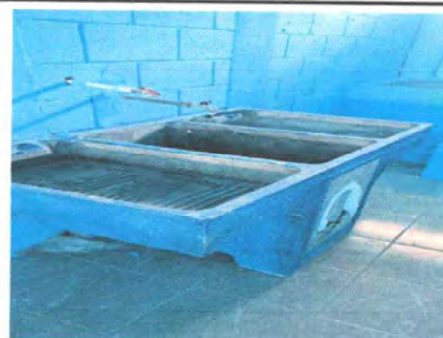
Foto 6: Sustrucción de pila de cemento de 2 lavaderos.
