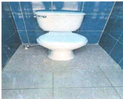
Foto 9: Sustitución de inodoro.
