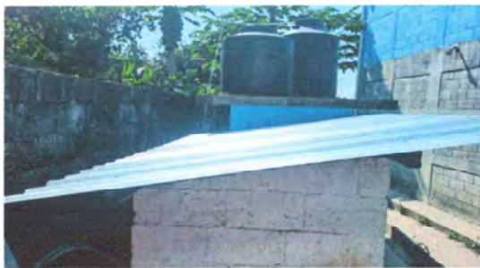
Foto 15: Sustitución de lámina por lamina troquelada aluzinc calibre 26.
