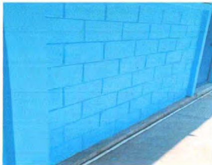
Foto 21: Resane y aplicación de pintura.
