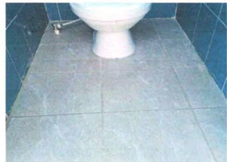
Foto 12: Suministro e instalación de piso cerámico.
