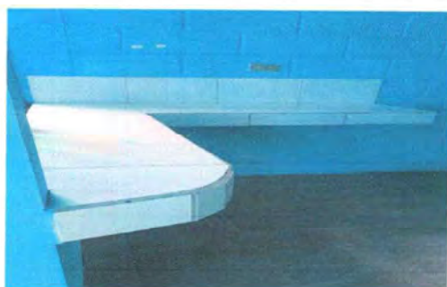
Foto 5: Suministro e instalación de azulejo en banco de trabajo.
