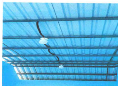
Foto 4: Sustrucción de Sistema eléctrico.
