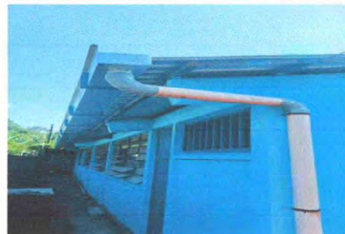
Foto 18: Sustitución de canal de metal.
