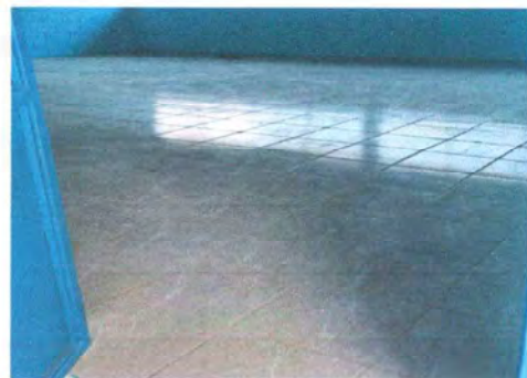
Foto 22: Suministro e instalación de piso Cerámico.
