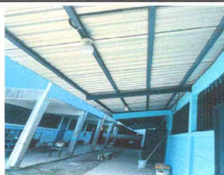
Foto 20: Sustitución de sistema Eléctrico.
