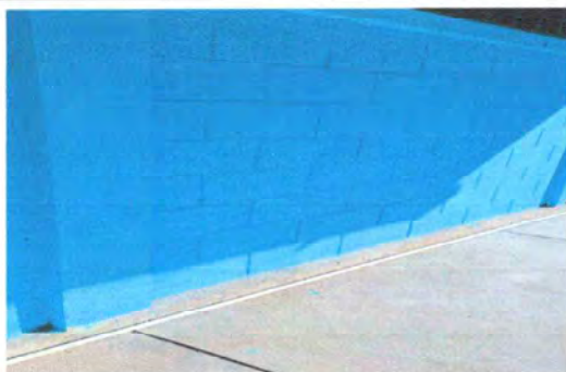
Foto 21: Resane y aplicación de Pintura.
