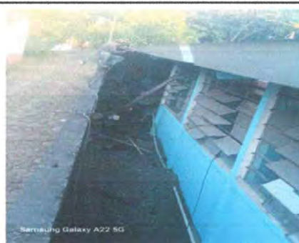
Foto 18: Sustitución de canal de metal.
