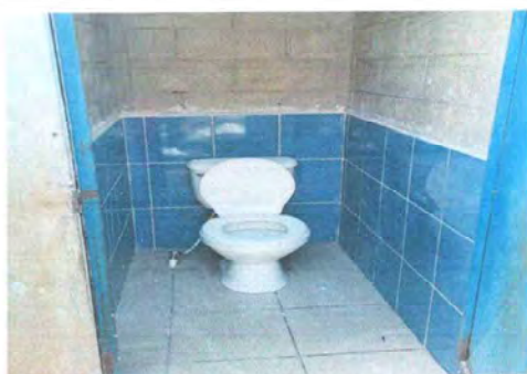
Foto 9: Sustitución de Inodoro.
