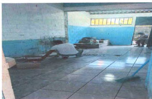
Foto 3: Sustrucción piso cerámico.
