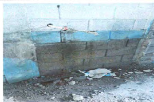
Foto 6: Sustrucción de pila de 2 lavaderos.
