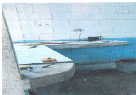
Foto 5: Instalación de azulejo en banco de trabajo.
