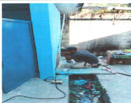
Foto 17: Sustitución de lavamanos.
