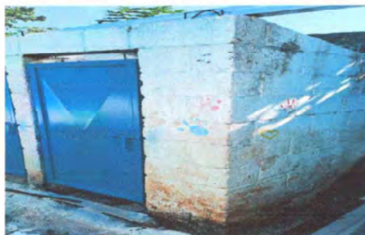
Foto 15: Sustitución de lámina.
