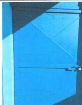
Foto 10: Mantenimiento de puerta.
