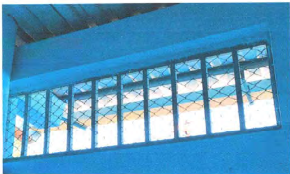
Foto 7: Mantenimiento de balcones de metal.
