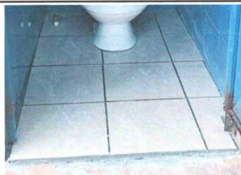
Foto 12: Suministro e instalación de piso cerámico.
