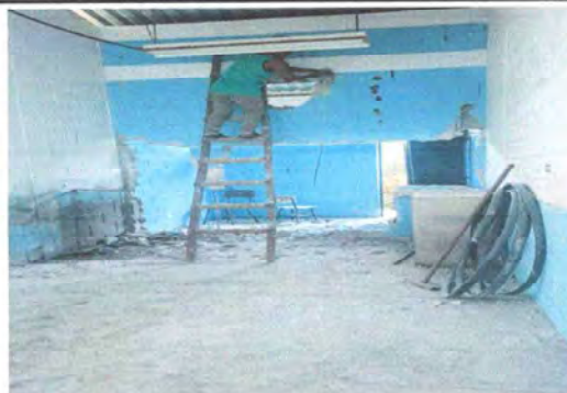
Foto 2: Mejoramiento de muro.
