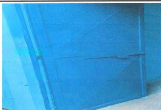
Foto 19: Mantenimiento de puertas de Metal.
