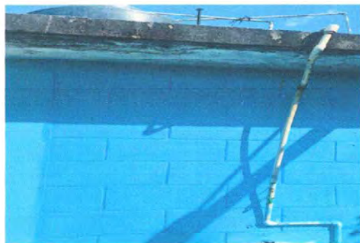
Foto 13: RESANE Y APLICACIÓN DE PINTURA.
