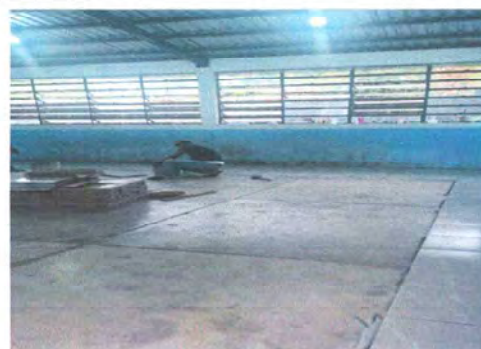
Foto 22: Suministro e Instalación de piso cerámico.
