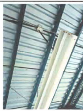
Foto 4: Se observa el sistema eléctrico en mal estado.
