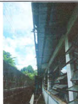
Foto 18: Se observa el canal de agua pluvial deteriorado.
