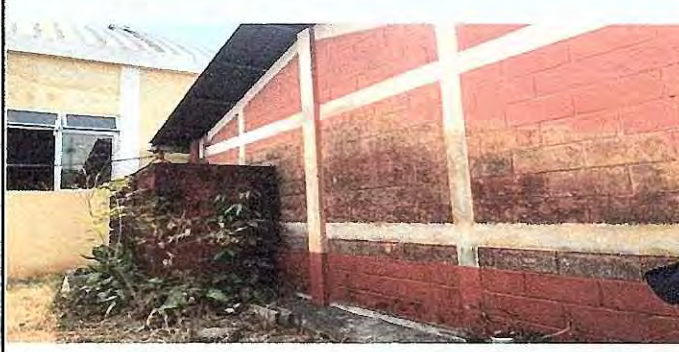
FOTO 4: Se observa el mal estado del muro, urge repello de aulas y baño.
