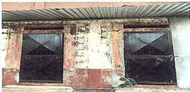
FOTO 13: Se observa el oxido y el mal estado de las puertas de los sanitarios.
