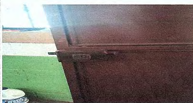
FOTO 10: Se observa el mal estado de las chapas, urge sustitucion.
