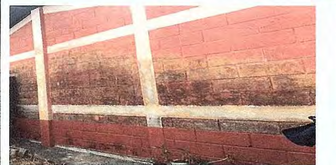
FOTO 5: Se observa la falta de cernido en muro
