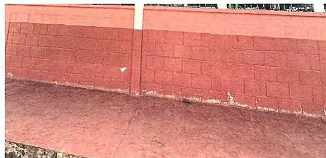
FOTO 12: Se observa el mal estado del piso, urge sustitucion a piso antideslizante.
