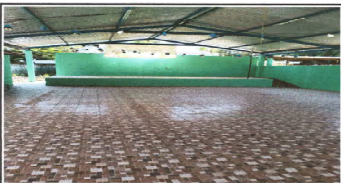
FOTO 11: Finalización de piso cerámico
