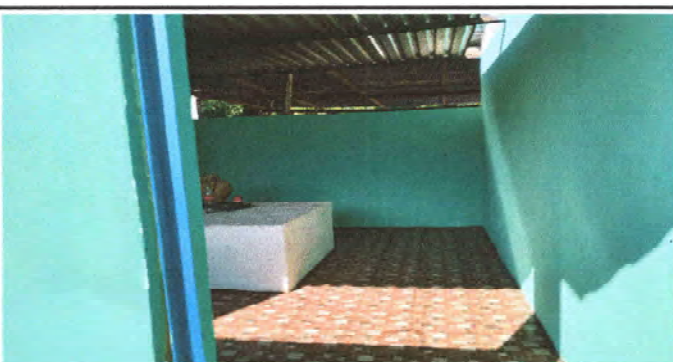
FOTO 6: Finalización de pintura en paredes
