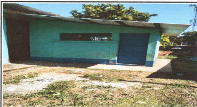
FOTO 8: Finalización de colocación de puertas.
