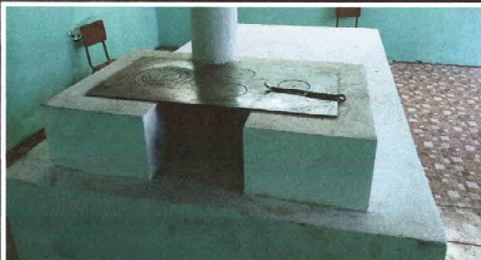
FOTO 1: Finalización de colocación de estufa
