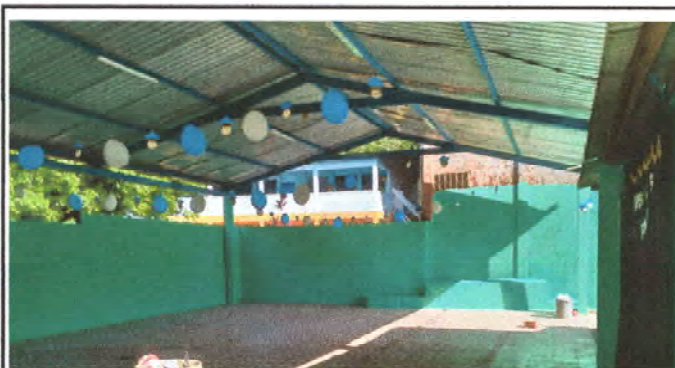
FOTO 10: Finalización de aplicación de pintura
