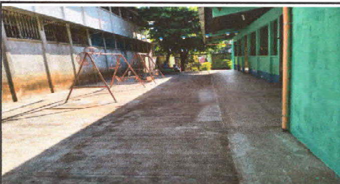
FOTO 9: Finalización de torta de concreto en patio.
