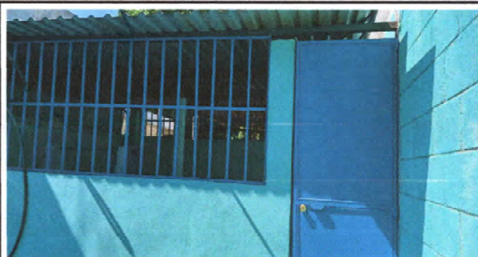
FOTO 3: Finalización de mejora en muo de cocina
