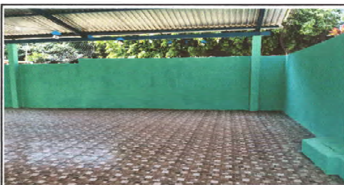
FOTO 12: Finalización de repello en muro.
