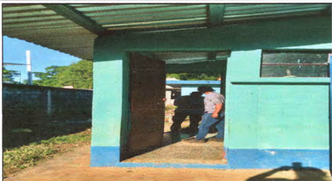
FOTO 7: Se observa el proceso de colocacion de puerta
