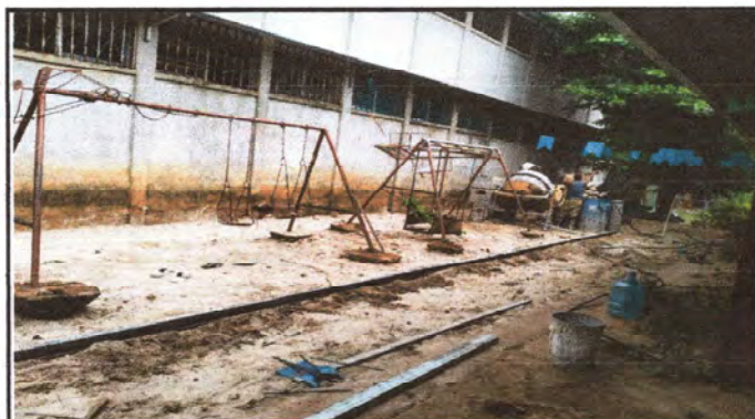
FOTO 9: Se observa el suministro de concreto en patio.
