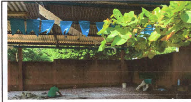
FOTO 12: Se observa el proceso de repello en muro.
