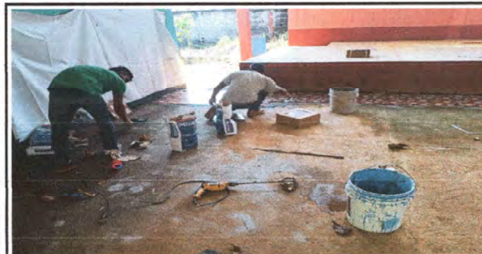
FOTO 11: Se observa la colocacion de piso ceramico en salon.
