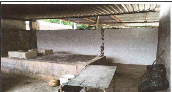
FOTO 5: Se observa el proceso de repello en pared.
