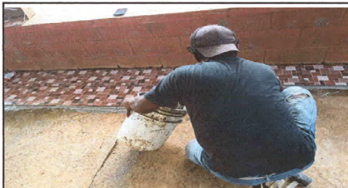
FOTO 4: Se observa el proceso de colocacion de piso ceramico.
