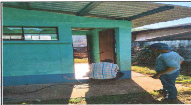
FOTO 8: Se observa la colocacion de puerta
