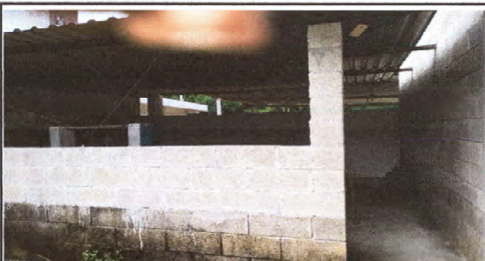
FOTO 3: Se observa el proceso de mejora en muro de cocina.
