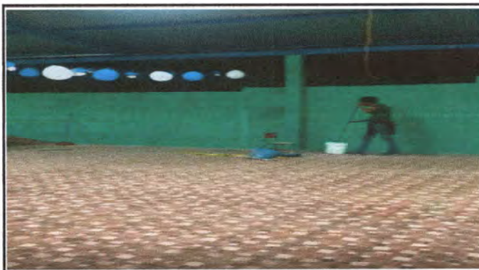
FOTO 10: Se observa el proceso de aplicacion de pintura en pared.
