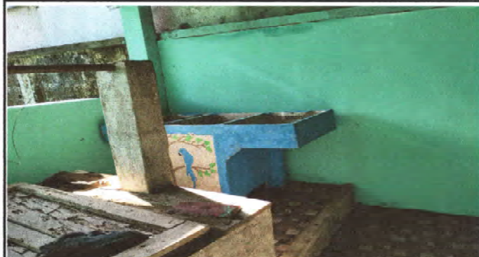
FOTO 2: Se observa el proceso de colocacion de pila
