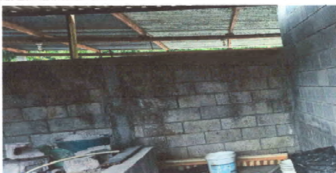
Foto 5: Se observa que pared actualmente no cuenta con repello.
