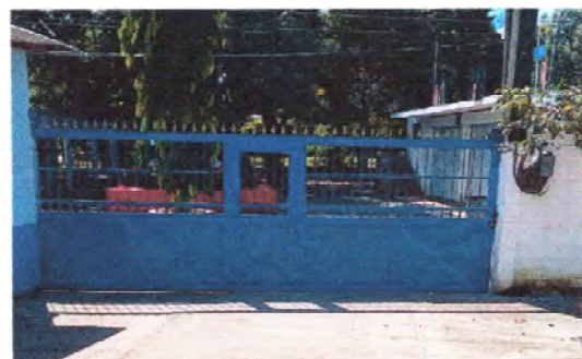
Foto 5: Finalización de sustitución de portón de ingreso.
