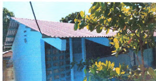
Foto 1: Finalización de mantenimiento de techo de aulas de párvulos
