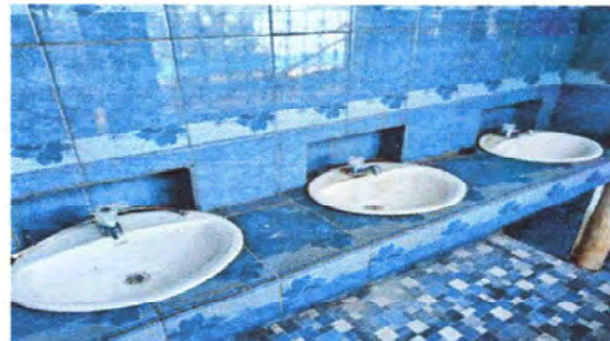
Foto 10: Finalización de mantenimiento a lavamanos
