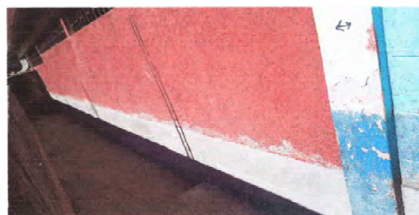
Foto 6: Finalización de Alisado de pared.
