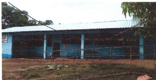
Foto 1: Finalización de colocación de lamina MaxAlum en aula
