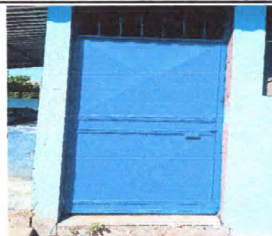
Foto 4: Finalización de mantenimiento de puertas que se encontraban en mal estado.
