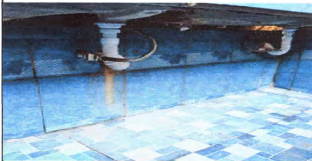
Foto 9: Finalización de proceso de Sustitución de llaves
