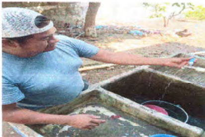
Foto 7: Finalización de sustitución de chorros.
