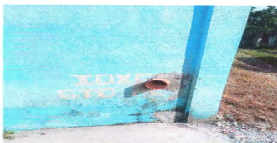
Foto 5: Finalización de salida de agua de banqueta a salida principal.
