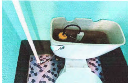
Foto 8: Finalización de cambio de accesorios de sanitario, por deterioro y fuga de agua.
