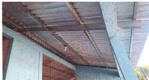
Foto 2: Finalización de colocación de estructura metálica en aula.
