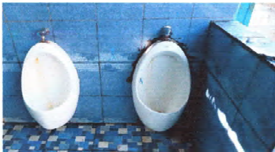
Foto 11: Se observa el proceso de mantenimiento a mingitorios
