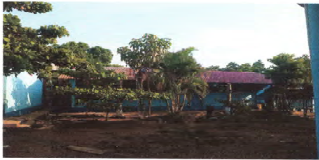
Foto 1: Se observa el proceso de mantenimiento de la lámina troquelada de aulas de párvulos.
