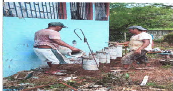
Foto 4: Se observa proceso de cambio de Chimeneas.
