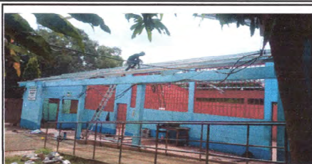
Foto 2: Se observa el seguimiento de la colocacion de la estructura metálica
