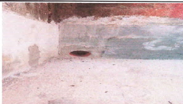
Foto 5: Se observa el proceso implementación de salida de agua pluvial de banqueta a calle.
