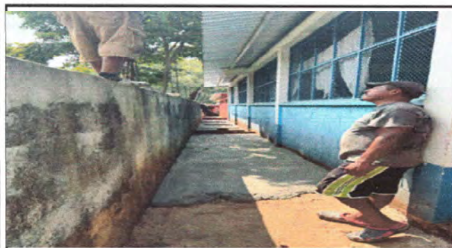
Foto 3: Se observa el seguimiento de fundición de banqueta en aulas de párvulos.
