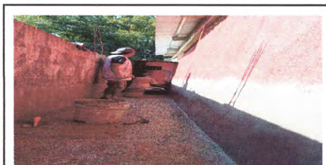
Foto 6: Se observa el proceso de alisado de pared por filtración de agua.
