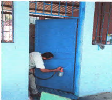
Foto 3: Se observa el mantenimiento de puerta de cocina y aula
