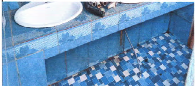
Foto 10: Se observa el proceso de mantenimiento a lavamanos
