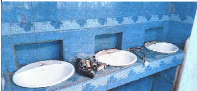
Foto 9: Se observa el proceso de Sustitución de llaves
