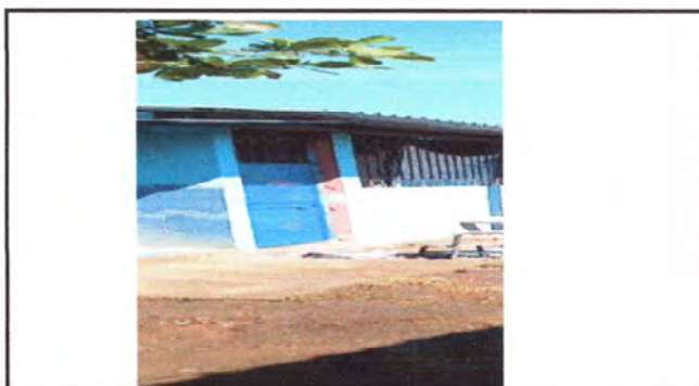
Foto 4: Se observa la reparacion de puertas que se encontraban en mal estado (cocina)
