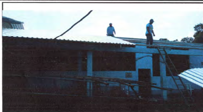
Foto 1: Se observa el seguimiento de colocacion de lámina de zinc
