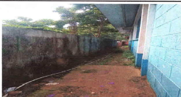
Foto 3: Se observa acumulación de agua y filtración a aulas de párvulos. Banqueta
