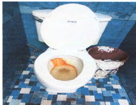
Foto 8: Accesorios de sanitario, por deterioro y fuga de agua.
