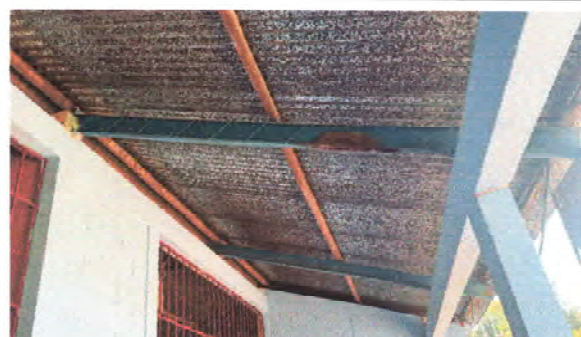
Foto 2: Se observa mal estado de la estructura metálica
