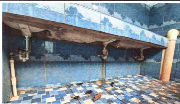
Foto 10: Mantenimiento a lavamanos
