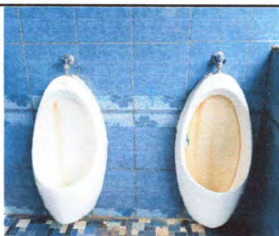
Foto 11: Mantenimiento a Mingitorios
