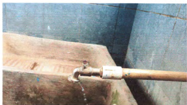
Foto 7: Sustrucción de Chorros.
