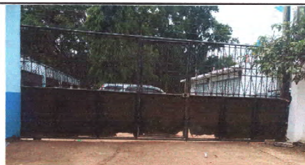
Foto 5: Portón de Ingreso en mal estado, se descuadro y no corre
