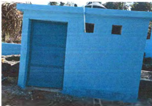
Foto 8: Se observa el matenimiento realizado al área del pozo.
