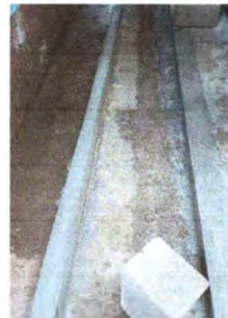
Foto 2: Se observa la nueva cuneta.
