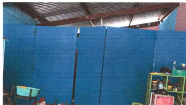
Foto 4: Se puede observar el nuevo entrepaño realizado.
