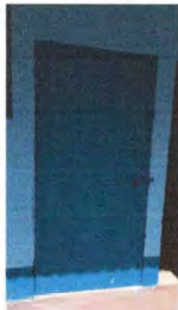
Foto 1: Se observa la sustitución de la puerta de metal.
