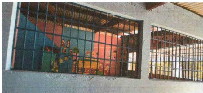
Foto 3: Se observa los balcones ya colocados.
