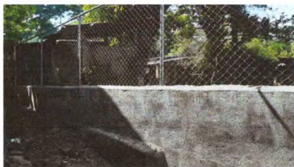
Foto 5: Se observa la nueva cerca perimetral.
