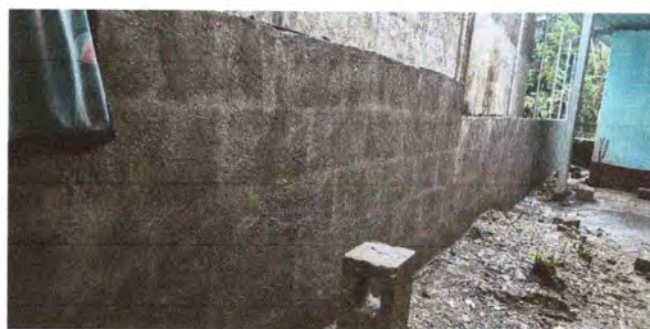
Foto 5: Se observa el inicio de la sustitución de la cerca perimetral.
