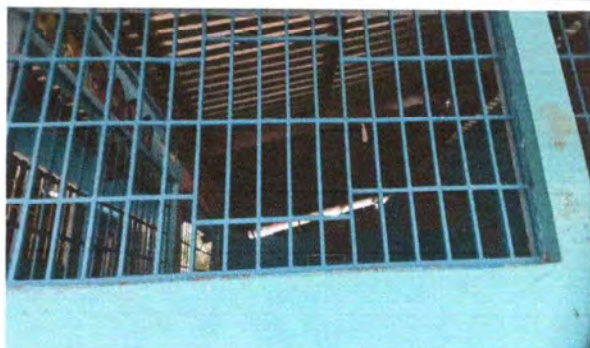
Foto 3: Se observa el inicio de la sustitución de balcones
