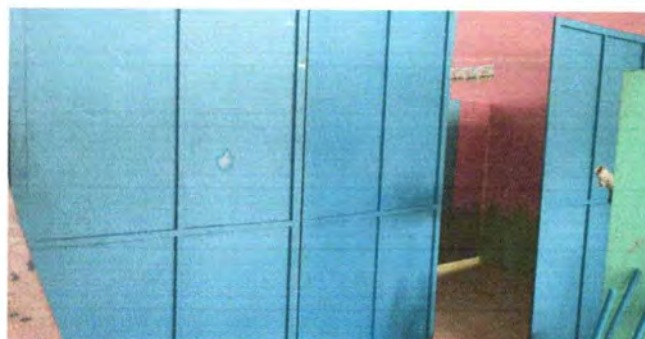
Foto 4: Inicio del cambio del entrepaño que estaba en mal estado.
