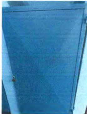
Foto 7: Se observa el inicio del cambio de puerta.
