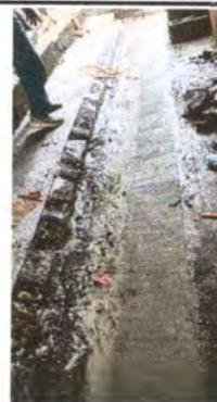
Foto 2: Se observa el inicio del mejoramiento de la cuenta de concreto
