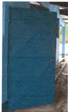
Foto 1: Se observa el inicio de la sustitución de puerta.
