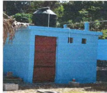
Foto 8: Se observa el inicio del mantenimiento al área del pozo.
