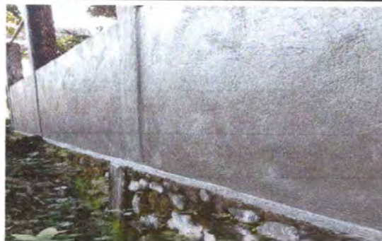
Foto 6: Inicio del repello y pintura a las paredes.
