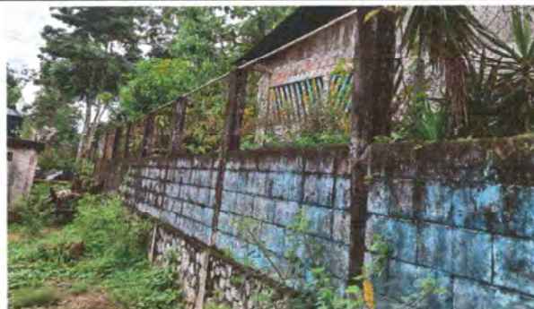
Foto 6: Se puede observar la necesidad del mantenimiento al muro con repello y pintura.
