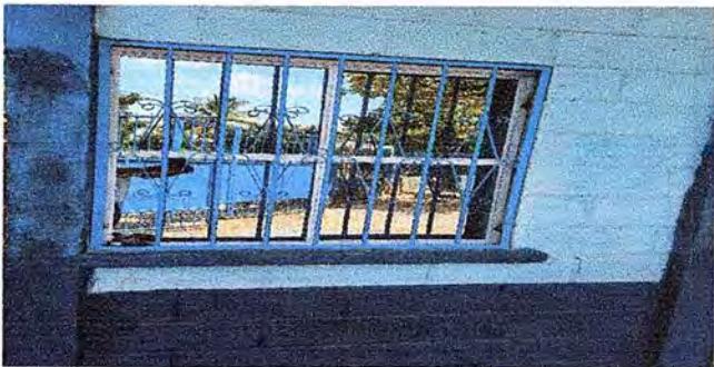
Foto 4: SE OBSERVA QUE SE INSTALO VENTANA NUEVA
