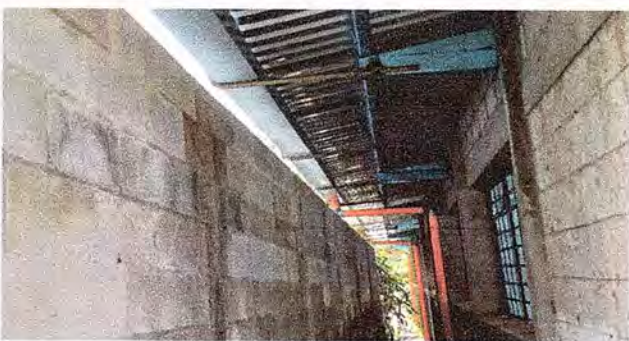
Foto 2: SE OBSERVA QUE YA SE FINALIZO CON LA PUESTA DE CANALES.
