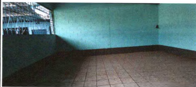
Foto 1: Se observa el piso cerámico nuevo colocado.
