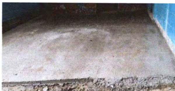
Foto 5: Se observa la nueva torta de concreto
