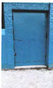
Foto 3: Se puede observar la nueva puerta instalada.
