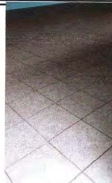
Foto 2: Se observa el piso cerámico nuevo instalado.
