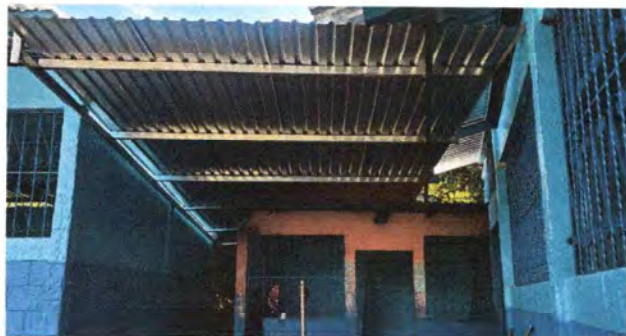
Foto 7: Se puede observar la sustitución de la lámina troquelada.
