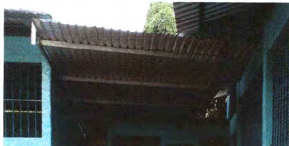
Foto 6: Se puede observar la nueva estructura de soporte de metal.
