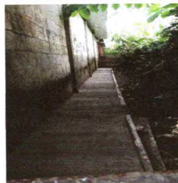
Foto 4: Se puede observar la sustitución de la banqueta de concreto.
