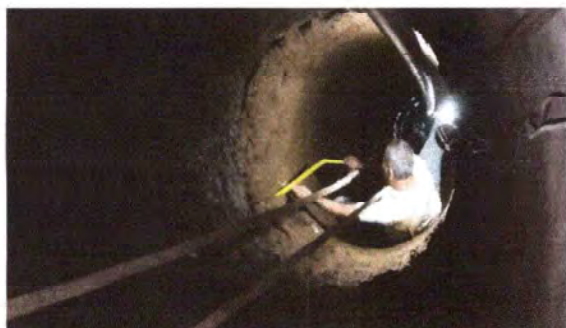
Foto 9: Se observa el inicio de la reparación del pozo.
