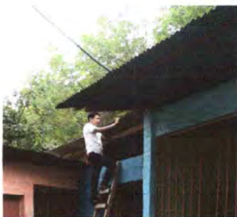
Foto 7: Se puede observar la sustitución de la lámina troquelada.
