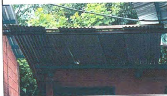
Foto 6: Se observa el mal estado de la estructura de soporte de metal
