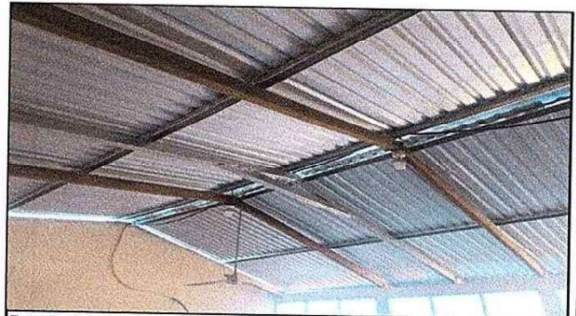
Foto 4: Cambio de estructura de madera por estructura metálica.
