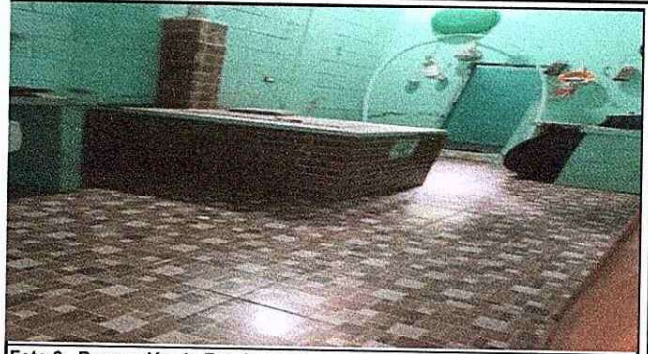
Foto 2: Reparación de Estufa Rural y cambio de piso.
