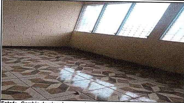
Foto1: Cambio de piso de concreto a piso cerámico.
