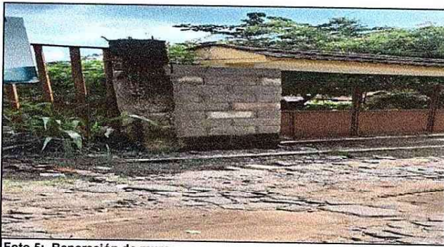
Foto 5: Reparación de muro.
