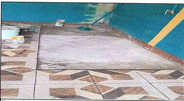
Foto 5: Colocación de piso cerámico en salón de clases
