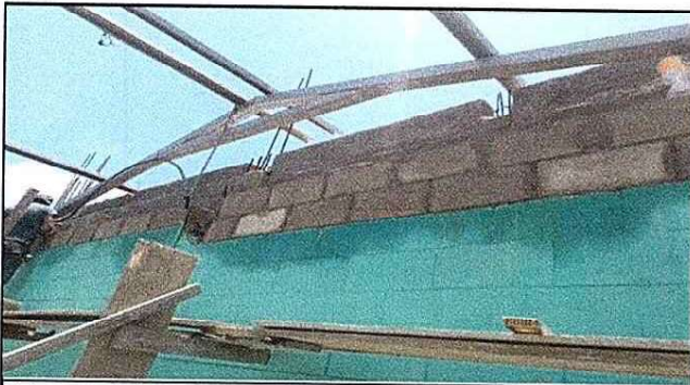
Foto 3: Reparación de muro de un aula.
