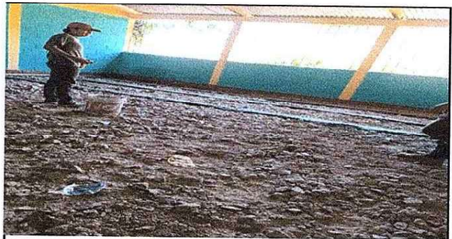
Foto 4: Cambio de piso de concreto.
