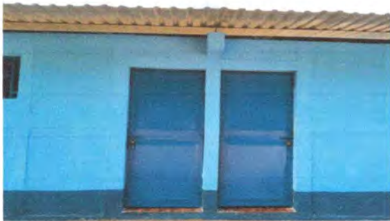
Foto 7: Se colocaron nuevas puertas externas.
