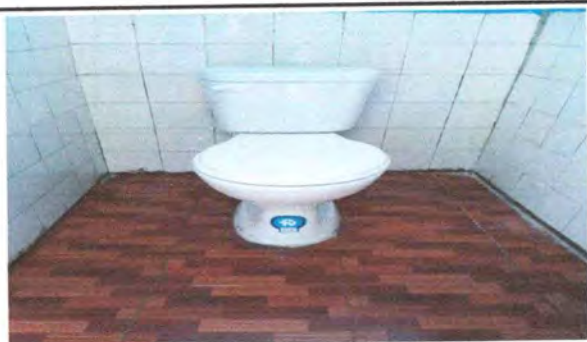
Foto 5: Se colocaron sanitarios nuevos.
