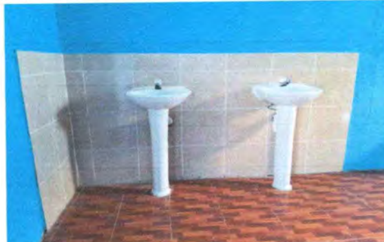
Foto 4: Se colocaron lavamanos nuevos.
