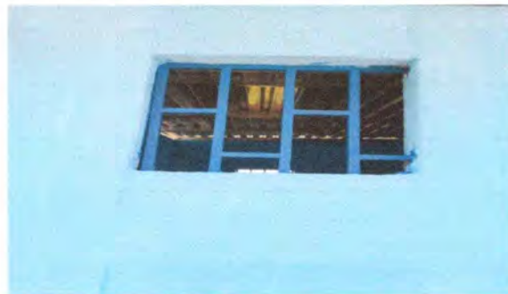
Foto 8: Los balcones se observan en buen estado.
