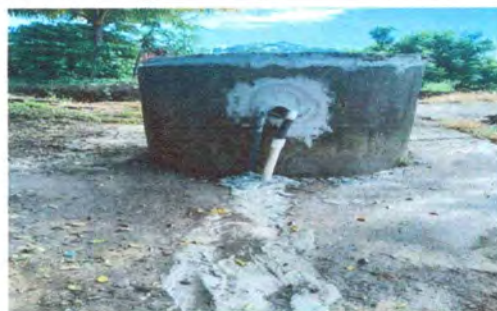
Foto 12: Se instalo una bomba de agua.
