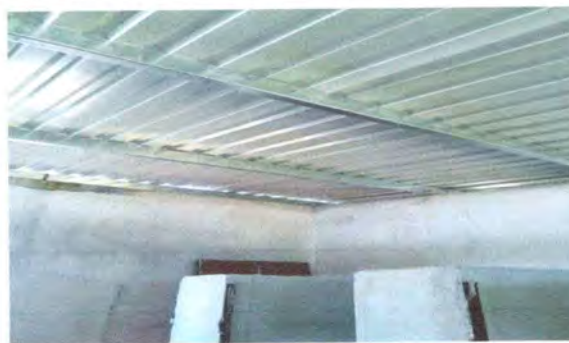
Foto 10: La estructura de soporte de los sanitarios se esta mejorando.
