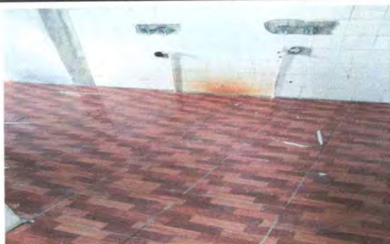
Foto 2: A los sanitarios se le está colocando piso cerámico.
