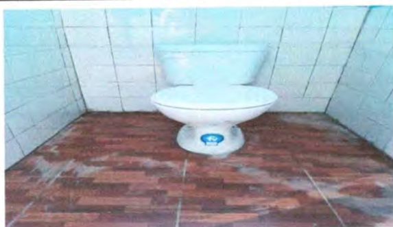
Foto 5: Los inodoros se están colocando.
