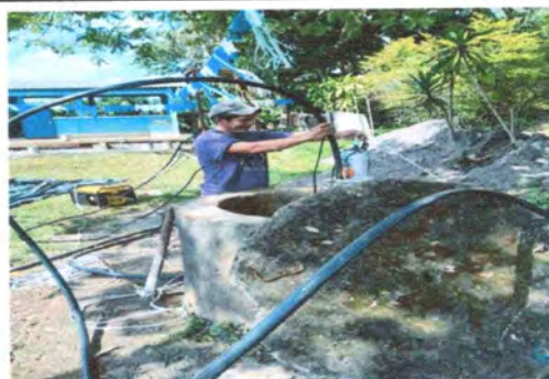
Foto 12: Se esta instalando la bomba de agua.
