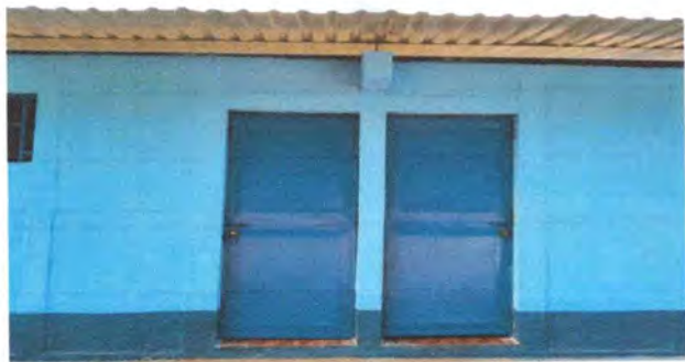
Foto 7: Las puertas externas de los sanitarios se estan cambiando.
