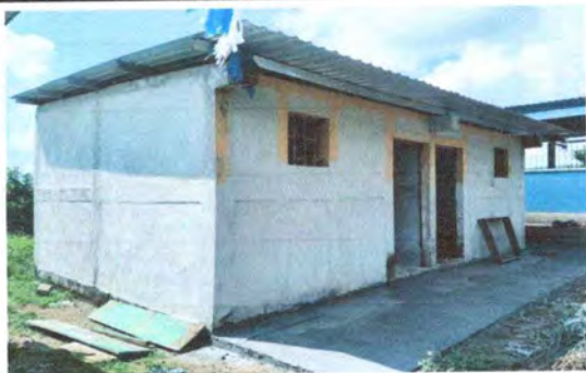
Foto 1: Las paredes de los sanitarios están siendo repelladas.
