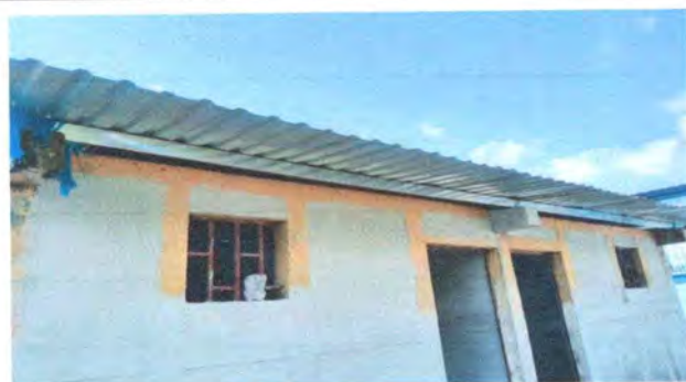
Foto 9: El techo de los sanitarios esta siendo cambiado.
