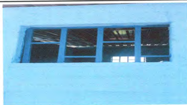
Foto 8: A los balcones se les esta dando mantenimiento.
