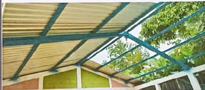
Foto 2: Se observa que ya han lijado, cepillado y pintado una parte de la estructura de soporte de metal.
