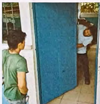
Foto 3: Se observa que están haciendo el mantenimiento correctivo a las puertas.
