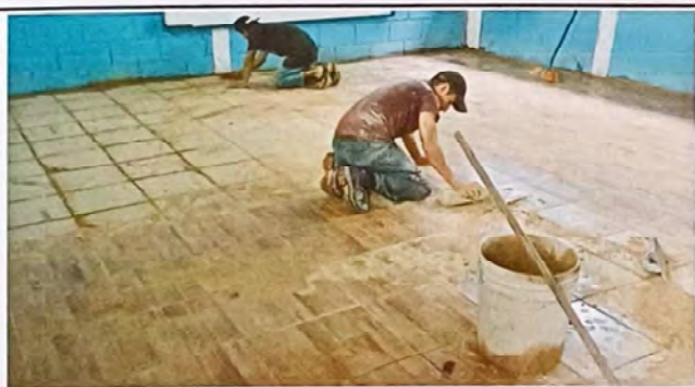
Foto 5: Se observa que se está sustituyendo el piso.
