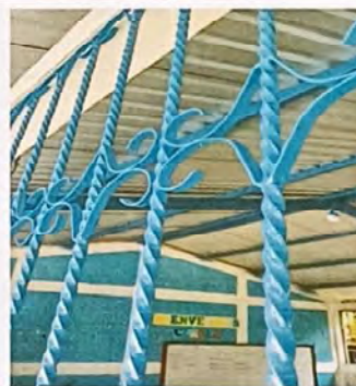
Foto 4: Se observa que han lijado, cepillado y pintado una parte de los balcones.
