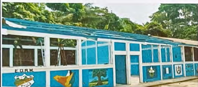
Foto 1: Se observa que han desmontado las láminas, y se encuentran lijando la estructura de soporte de metal.
