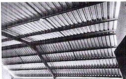
Foto 1: Colocación de la estructura de metal.
