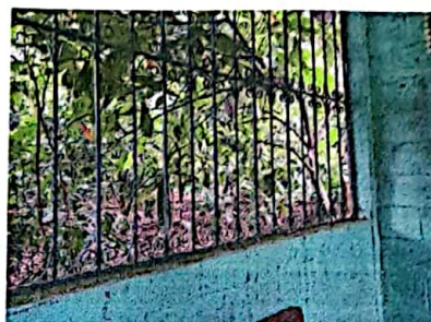
Foto 8: FOTOGRAFIA DEL ESTADO ACTUAL DE LOS BALCONES
