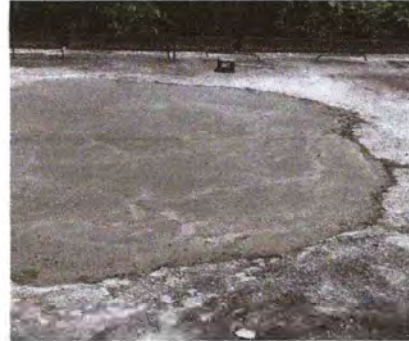
Foto 8: Se observa el mejoramiento de la terraza.
