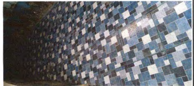
Foto 10: Se observa el piso antideslizante colocado.
