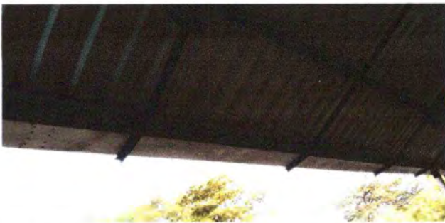
Foto 11: Se observa los canales de metal instalados.
