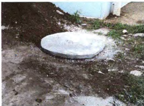
Foto 9: Se observa de tuberías de aguas negras.
