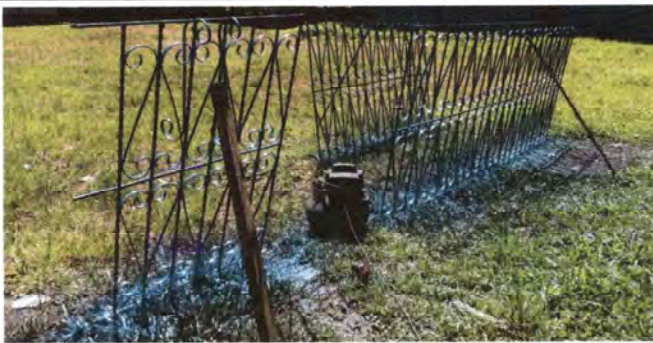
Foto 3: Se observa el mantenimiento a los balcones.
