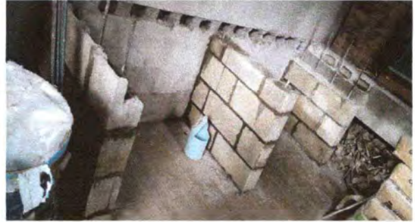
Foto 14: Se observa el inicio de la instalación del banco de trabajo.
