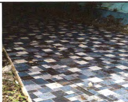
Foto 10: Se observa el proceso de colocación de piso antideslizante.
