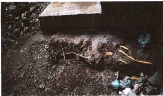
Foto 5: Inicio de reparación de la banqueta.
