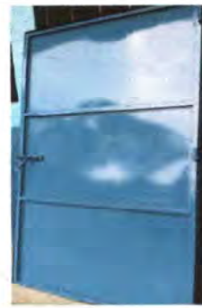
Foto 4: Se observa el mantenimiento a las puertas.
