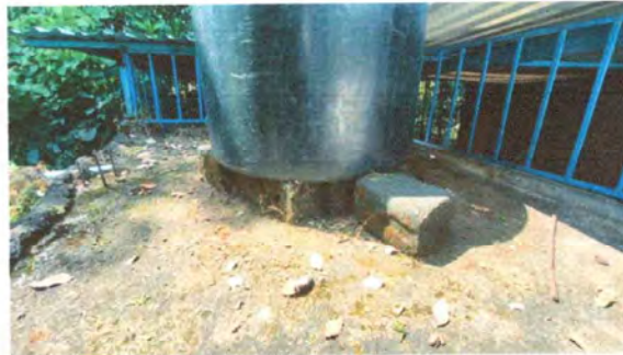
Foto 8: Se observa el mal estado de la terraza del pozo
