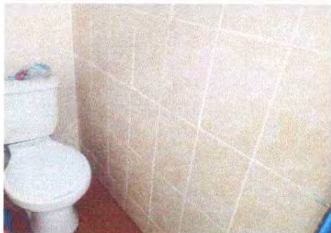
Foto 13: Se observa como quedo el azulejo de los baños
