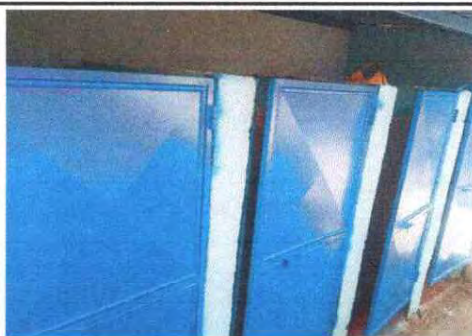
Foto 17: Se observa como quedo la puerta
