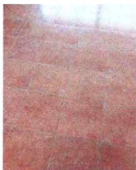
Foto 7: Se observa como quedo el piso ceramico
