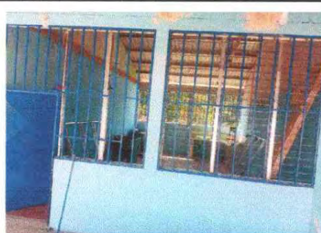
Foto 10: Se observa como quedaron los balcones
