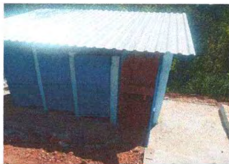
Foto 14: Se observa como quedo la sustitucion de lamina
