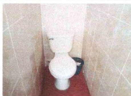
Foto 12: Se observa como quedaron los baños
