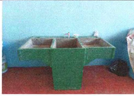
Foto 6: Se observa como quedo la pila
