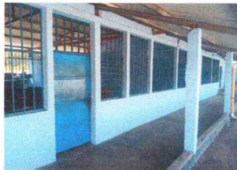
Foto 8: Se observa como quedo la aplicación de pintura
