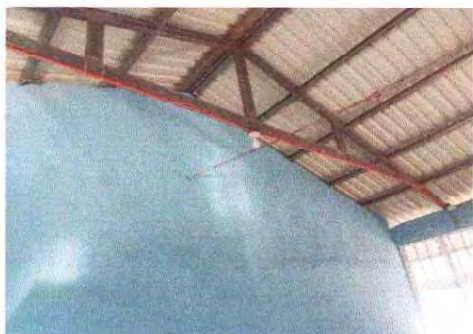
Foto 1: Se observa el muro
