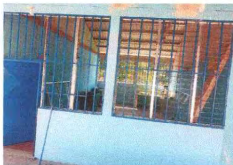
Foto 9: Se observa la colocacion de las ventanas
