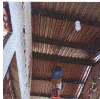
Foto 4: Se observa la instalación del sistema eléctrico
