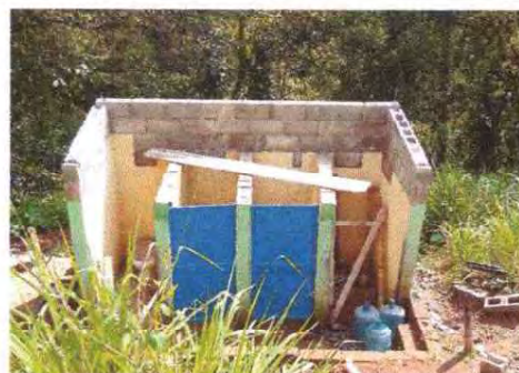
Foto 14: Se observa el cambio de lamina
