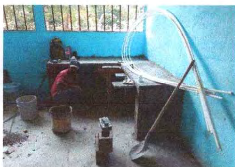
Foto 3: Se observa la elaboración del banco de cocina
