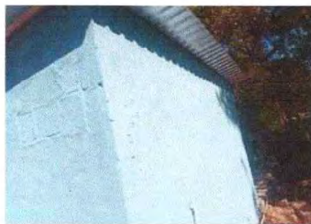
Foto 16: Se observa la aplicación de pintura
