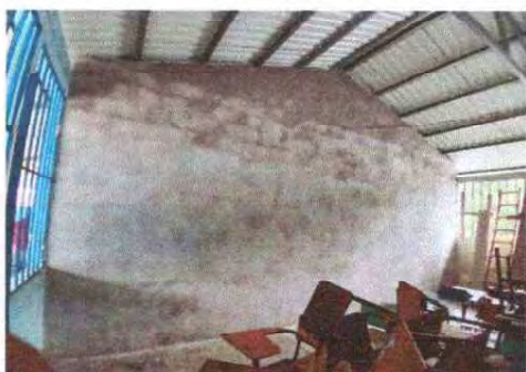
Foto 1: Se observa la ampliación del muro
