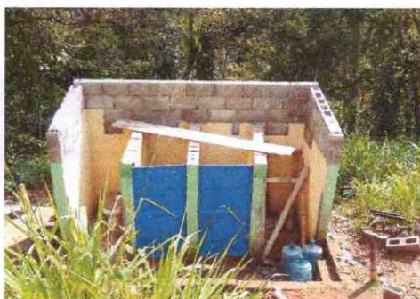
Foto 15: Se observa la estructura de metal
