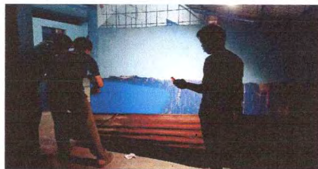
Foto 8: Se observa la aplicación de pintura
