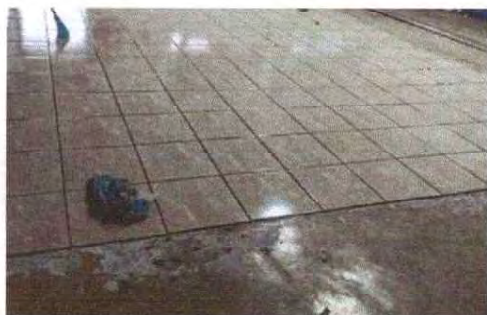
Foto 7: Se observa la colocacion de piso ceramico
