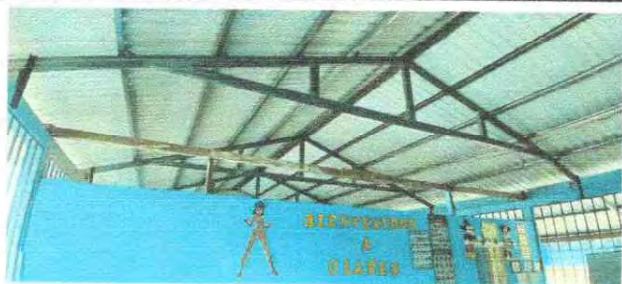
Foto 1: Se observa la necesidad de conformar el muro
