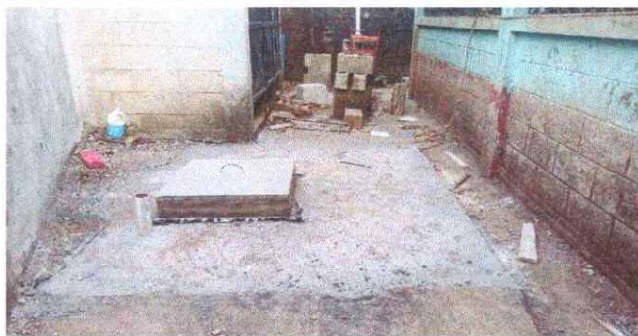
Foto 3: Se observa como quedo la fosa septica
