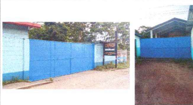
Foto 4: Se observa como quedo el porton despues del mantenimiento
