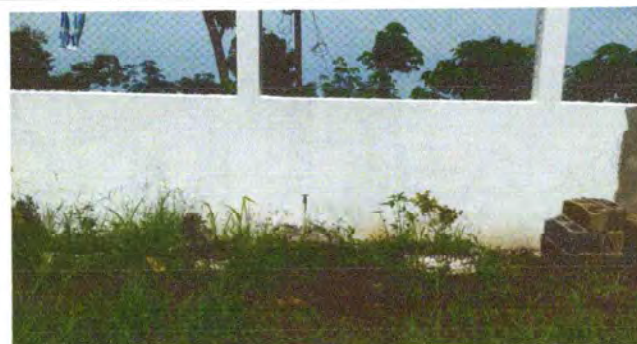
Foto 4: Se observa como quedo la tubería principal de agua
