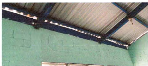
Foto 15: Se observa como quedo la conformacion del muro
