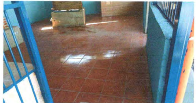
Foto 8: Se observa como quedo el piso ceramico
