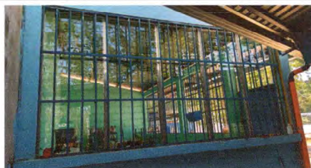
Foto 14: Se observa como quedo la colocacion de ventana mas vidrio
