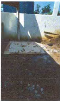
Foto 9: Se observa como quedo la caja de registro
