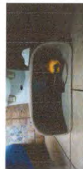
Foto 10: Se observa como quedo el cambio de accesorios
