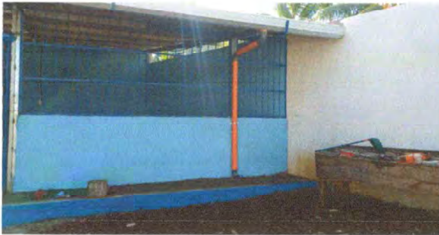
Foto 7: Se observa como quedo el canal para agua
