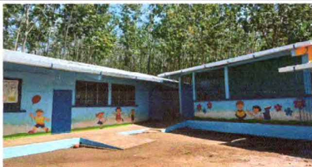
Foto 13: Se observa como quedo el cambio de canal para agua
