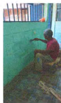
Foto 16: Se observa la aplicación de pintura en muros
