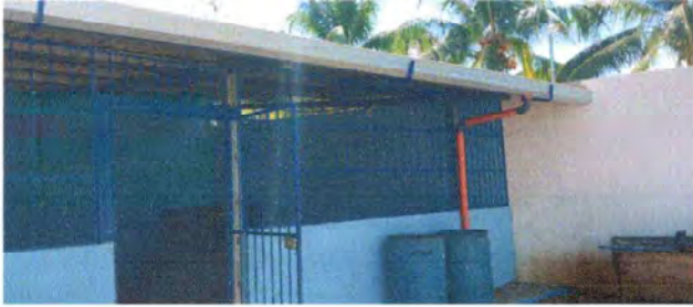
Foto7: Se observa la colocacion del canal para agua
