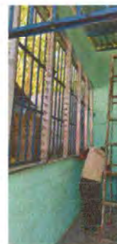
Foto 14: Se observa la colocacion de ventanas
