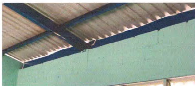
Foto 15: Se observa la conformacion del muro
