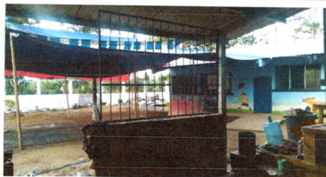
Foto 2: Se observa la colocacion del balcon de metal
