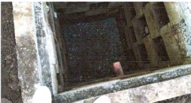
Foto 9: Se observa la colocacion de la caja de registro
