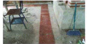
Foto8: Se observa la colocacion de piso ceramico
