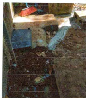
Foto 4: Se observa la instalacion de la tuberia
