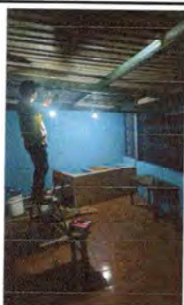
Foto 5: Se observa la instalacion del sistema electrico
