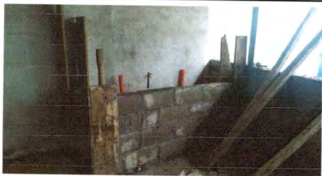
Foto1: Se observa la creacion de la pila
