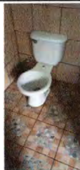
Foto 10: Se observa la necesidad de cambiár los accesorios de los baños
