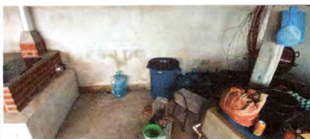
Foto 3: Se cuenta con la necesidad de crear un banco de cocina
