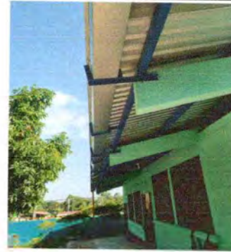
Foto 2: Terminación de la sustitución de lámina, por lámina troquelada aluzinc calibre 26.
