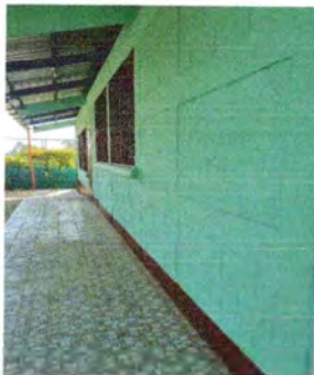
Foto 5: Finalización de aplicación de pintura látex acrílica en muros interiores y exteriores del establecimiento educativo.
