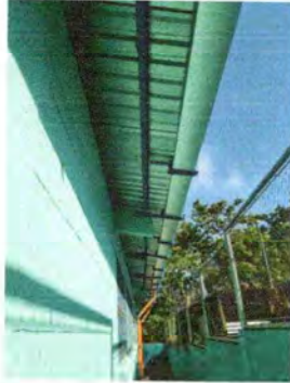
Foto 1: Finalización de la colocación de suministro de canal de metal para el desfogue de agua pluvial.
