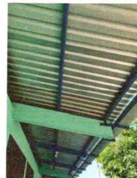
Foto 4: Terminación del mantenimiento a estructura de soporte de metal.
